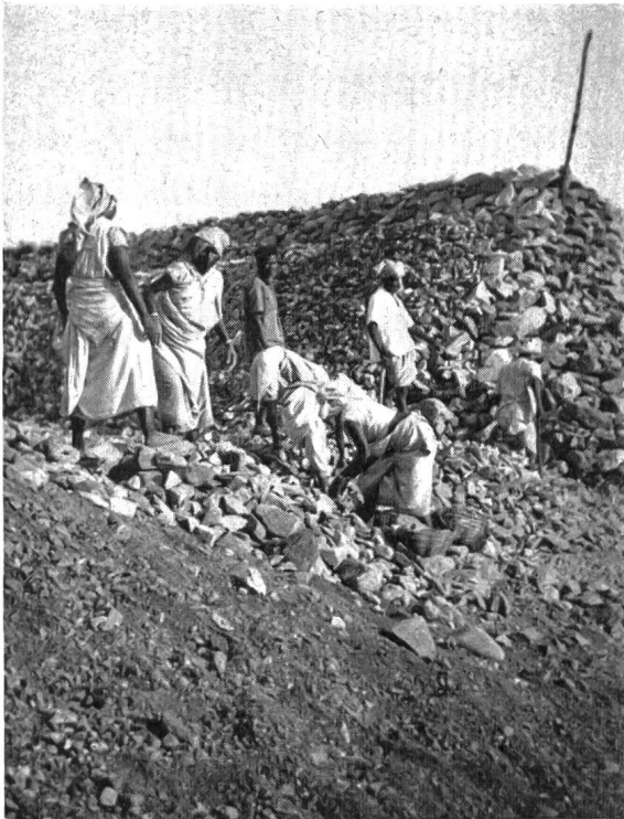
Abb. 9 Konar-Damm; Arbeiter und Arbeiterinnen beim Einbringen der Filterschichten (Photo A. Wackernagel)
