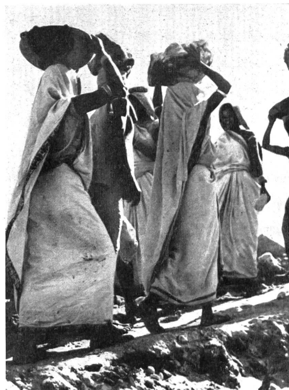
Abb. 10 Konar-Damm. Arbeiterinnen beim Einbringen der Steinschüttung (Photo K. Müller)
