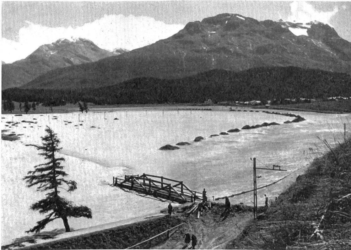
Abb. 1 Hochwasser vom 2./3. September 1956 zwischen Schlarigna/Celerina und Samedan. Der Flaz ist wiederum durchgebrochen, er hat die Weiden und das Innbett überflutet und darin viel Sand und Schlamm abgelagert; auch die Kantonsstraße ist unter Wasser. Im Wasser sind die nach den letzten Hochwassern aus dem Inn gebaggerten Sandhaufen sichtbar.
