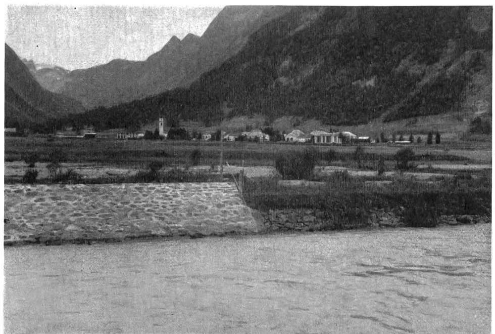
Abb. 14 Neue Dammbauten am Inn bei Bever; Vergleich mit den bestehenden Dämmen. Blick Richtung Val Bever.
