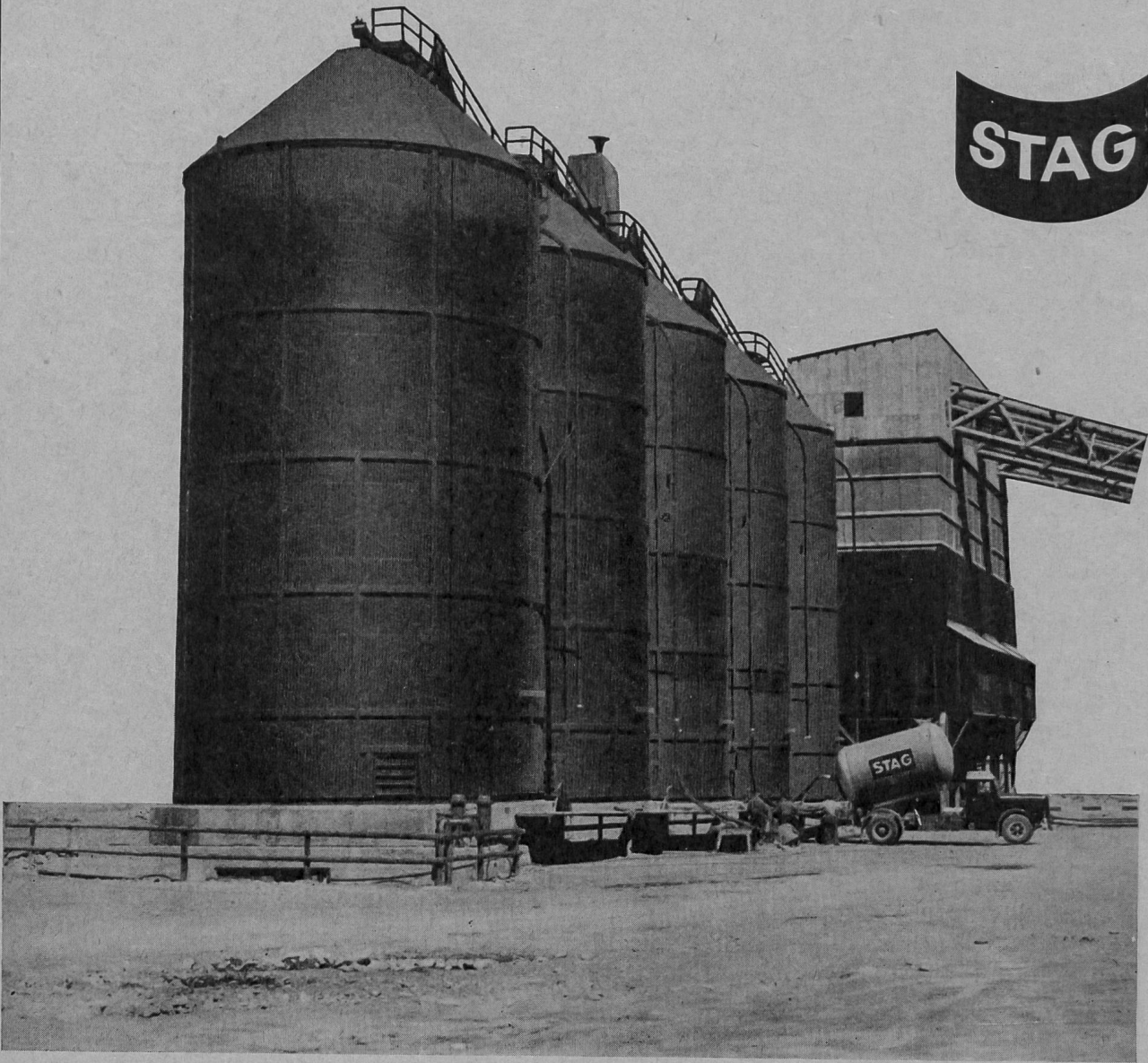
Tonpulver-Lagersilos der Stag auf Göschenalp — 5 Silos à 1000 m 3 Inhalt
