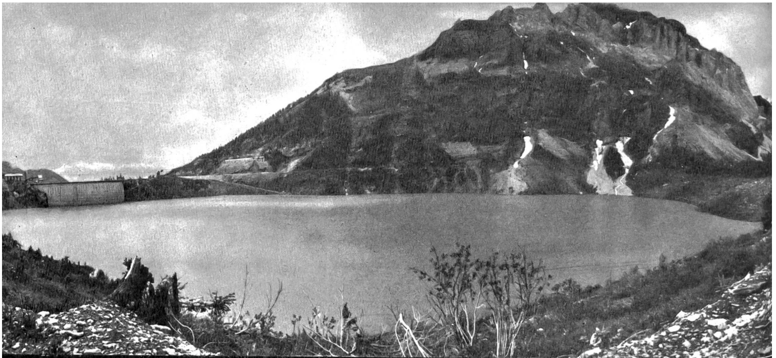
Stausee Zeuzier (Electricité de la Lienne S. A.)
