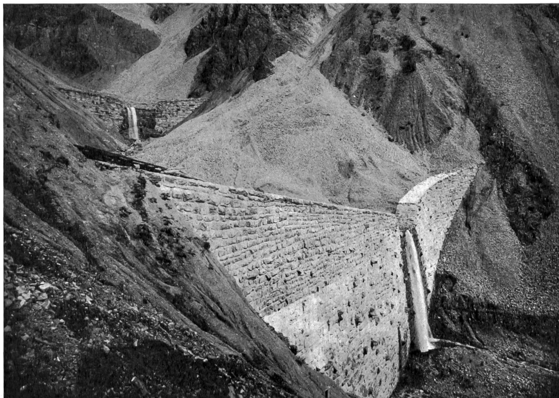
Abb. 2 Sperrn IVa und V im Lammbach, Aufnahme vom August 1913
