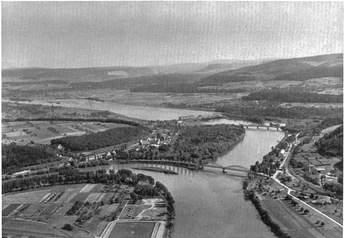
Abb. 15 Typisches Flußkraftwerk; Kraftwerk-Anlage Klingnau an der Aare (rechts); im Vordergrund Mündung der Aare in den Rhein bei Koblenz
