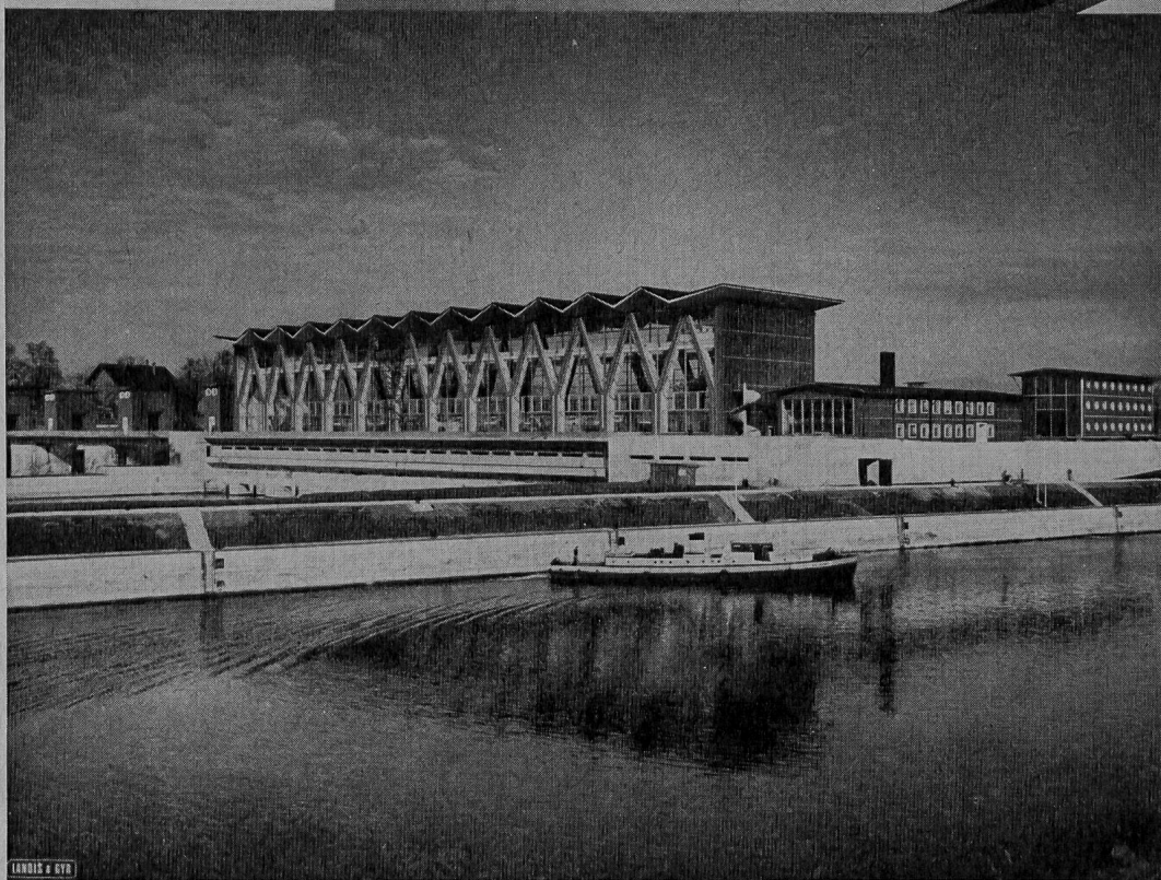
Kraftwerk Birsfelden mit Fernzählanlage Landis & Gyr
