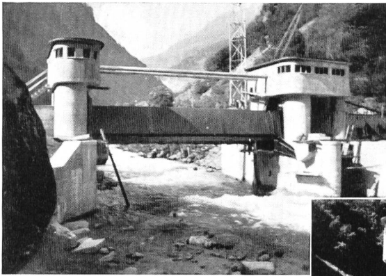
OBERWASSERSEITE BEIDE SEGMENTE GEHOBEN
