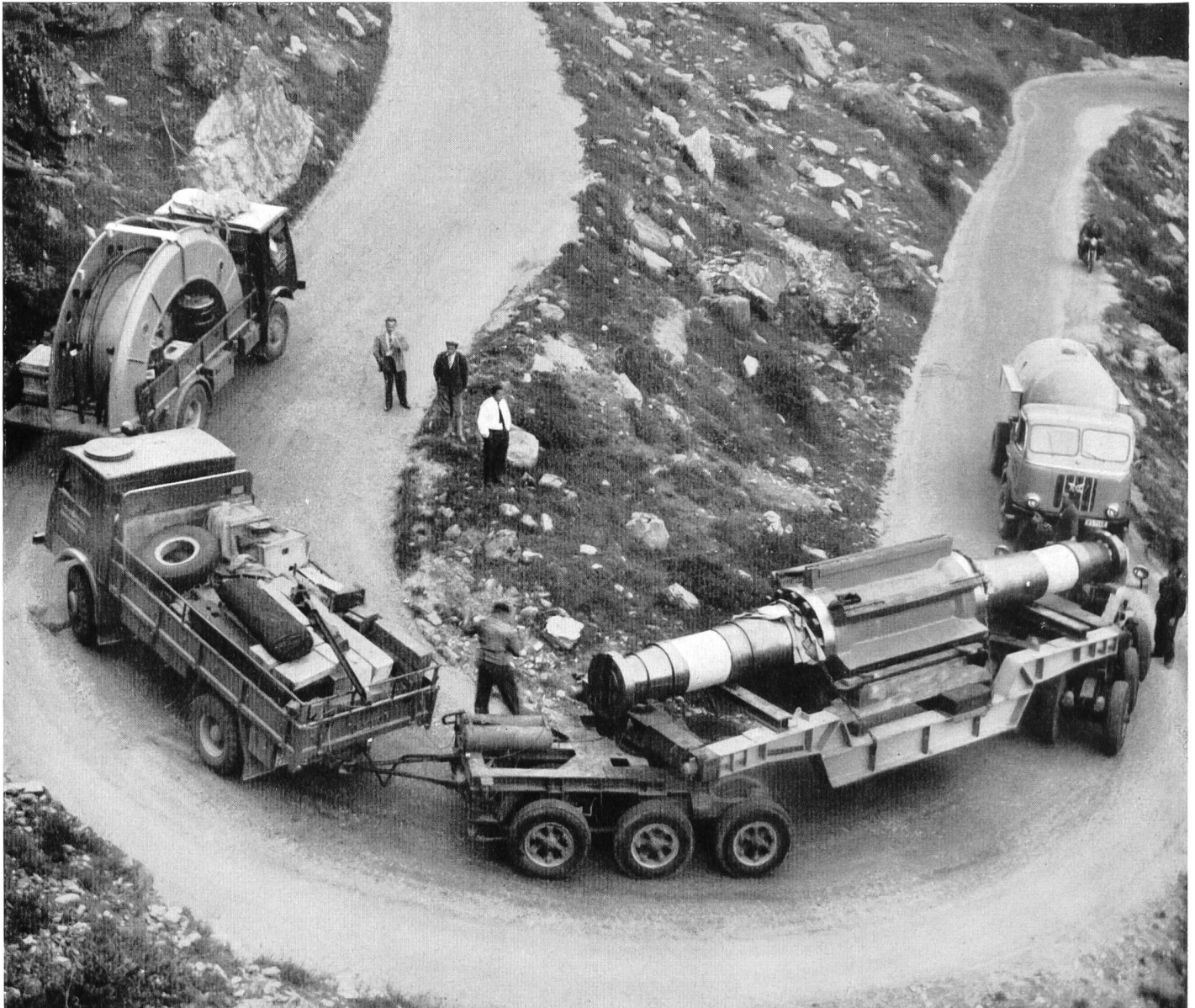
Transport eines 48-Tonnen-Rotors mit Welle für das Kraftwerk Fionnay auf steiler Gebirgsstraße mit engen Kurven und starker Querneigung.
