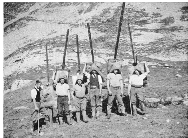
Bild 7 Trägergruppe mit Material für die Sondierbohrungen 1944/45.
