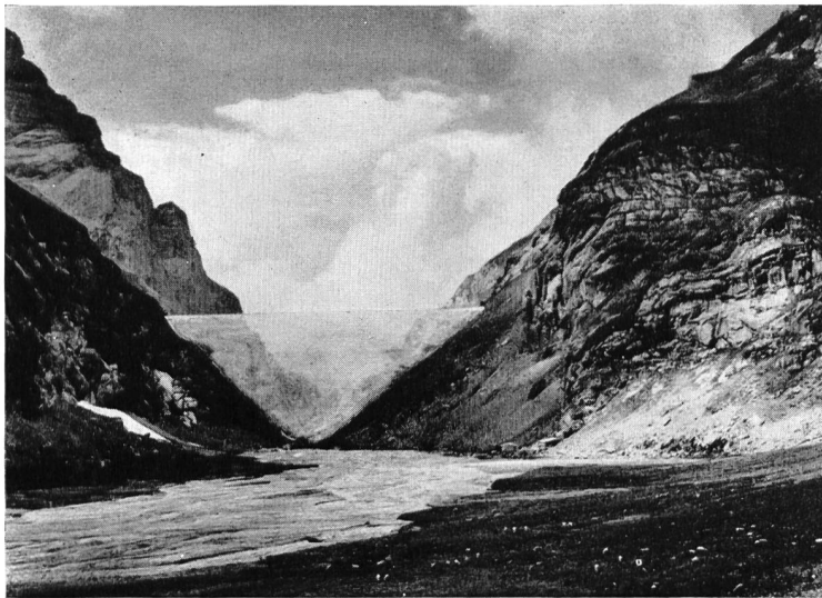
Bild 4 Limmernboden, Sperrstelle mit eingezeichneter Staumauer.
