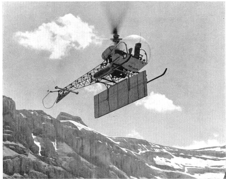
Bild 8 Transport einer Barackenwand im Sommer 1956 mit Helikopter. (Photo H. B. Burgunder, Air News Service, Bern)
