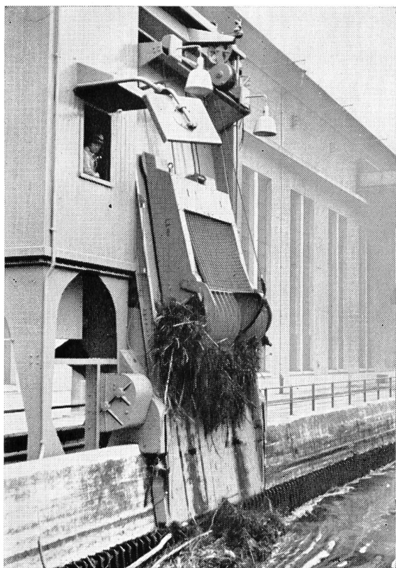
Maschine während dem Reinigen
