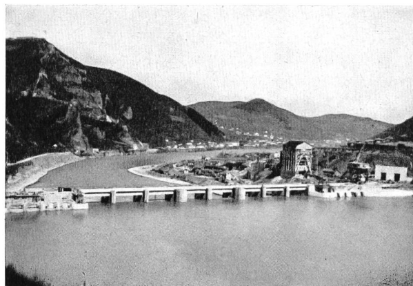
Fig. 102 L'usine hydroélectrique de Zvornik, vue d'amont.
