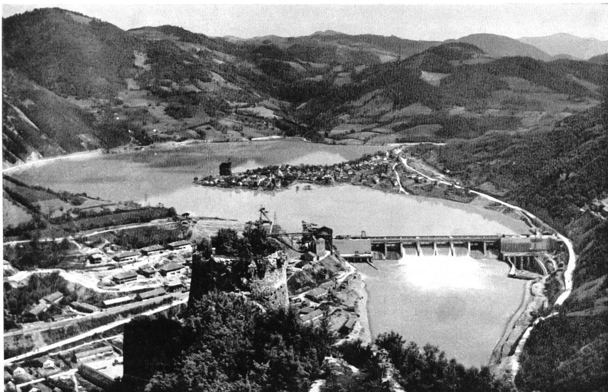
Fig. 101 L'usine hydroélectrique de Zvornik sur la Drina (84 MW, chute 21 m, débit installé 540 m 3 /sec), construite après la guerre.
