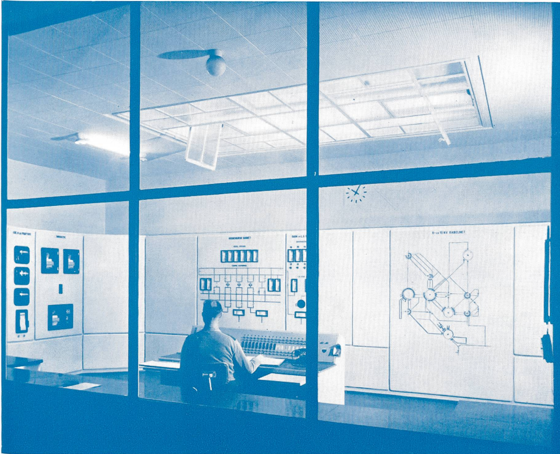
Meßzentrale für das Gasnetz der Gemeinde-, Energie- und Transport- betriebe in Utrecht, Holland
