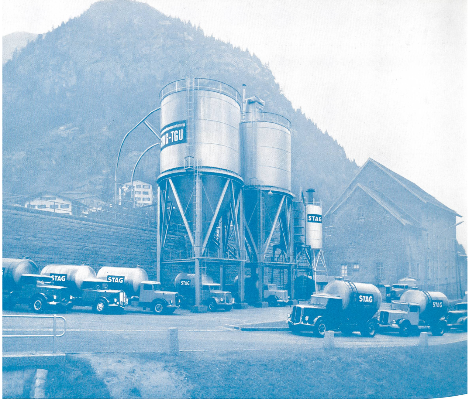
Umschlagsanlage in Göschenen: 2 Tonpulversilos von total 840 m 3 Inhalt, 2 Zementsilos à je 65 t Fassungsvermögen, 8 Tonpulver-Straßentransportbehälter von je 11,5 m 3 Inhalt
