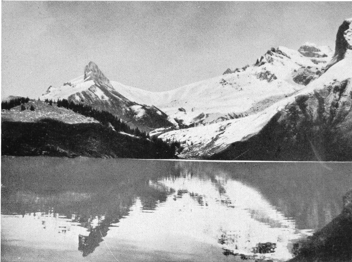
Bild 2 Bannalpsee des Kantonalen Elektrizitätswerkes Nidwalden
