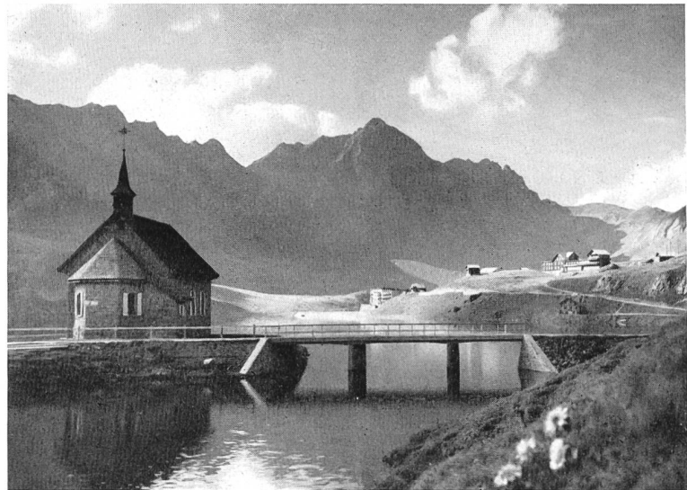
Bild 7 Fruttwerk des Elektrizitätswerkes des Kantons Obwalden, gestauter Melchsee
