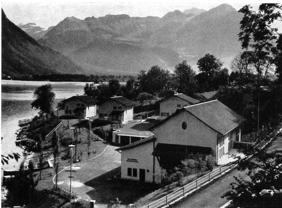
Bild 4 Kraftwerk Isenthal des Elektrizitätswerkes Altdorf, Zentrale Bolzbach und Wohnkolonie am Urnersee
