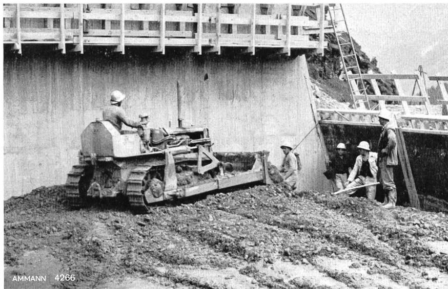
Betonverteilen mit Caterpillar-Bulldozer beim Staumauerbau
