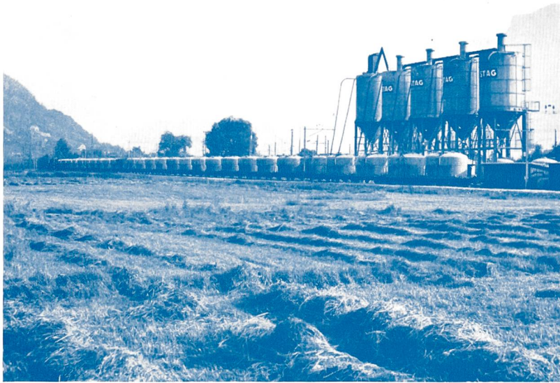
Umschlagsanlage der STAG in Landquart
