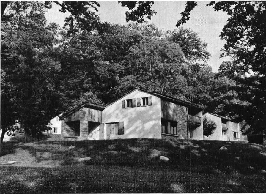
Bild 5 Die im prächtigen Kastanienwald ob Castasegna geschmackvoll angelegte Wohnsiedlung für das Kraftwerk-Personal
