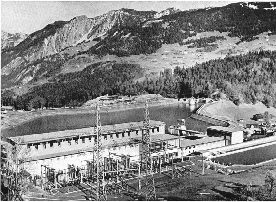
Bild 2 Krafthaus Lünsersee mit Ausgleichbecken Latschau; Aufnahme Spätherbst 1958.
