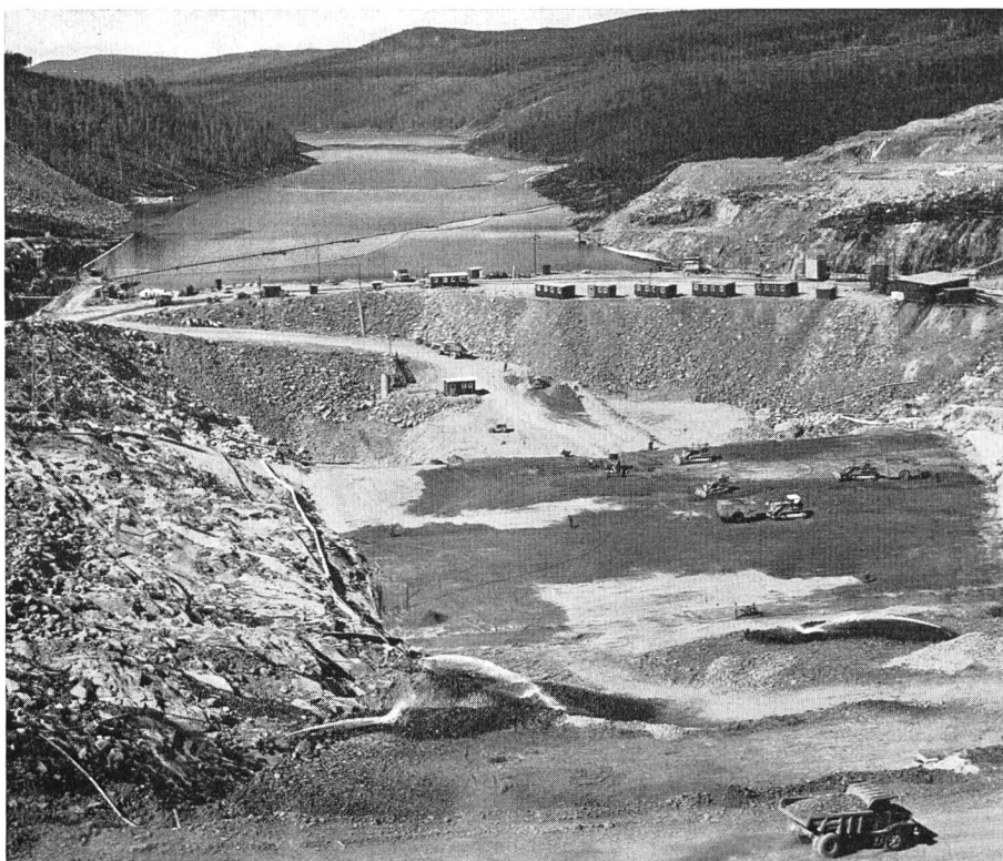
Bild 1 Staudamm Trängslet am Österdalälven; Blick stromaufwärts, im Vordergrund Einbau des Dammkernes. Durch den 120 m hohen Staudamm (7,2 Mio m 3 ) wird bei 25 m Spiegelschwankung ein Speichervolumen von 700 Mio m 3 geschaffen. (Photo Sven Berg, Falun)
