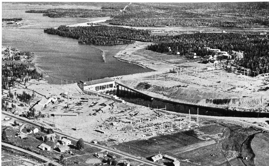
Bild 12 Wasserkraftanlage Petäjaskoski am Kemijoki (Bruttogefälle 20,5 m, 150 MW, 660 GWh) der Kemijoki Oy, seit 1957 in Betrieb (Photo Roos, Helsinki)
