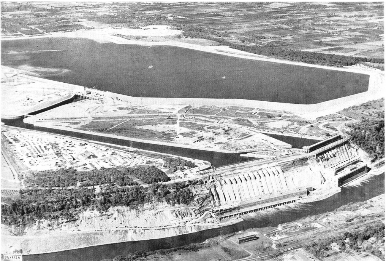
Bild 2 Kraftwerke Sir Adam Beck No. 1 und 2
