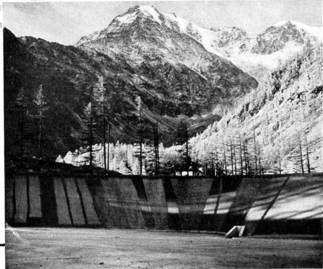
Ausgleichsbecken «Eggen» der Energie Electrique du Simplon
