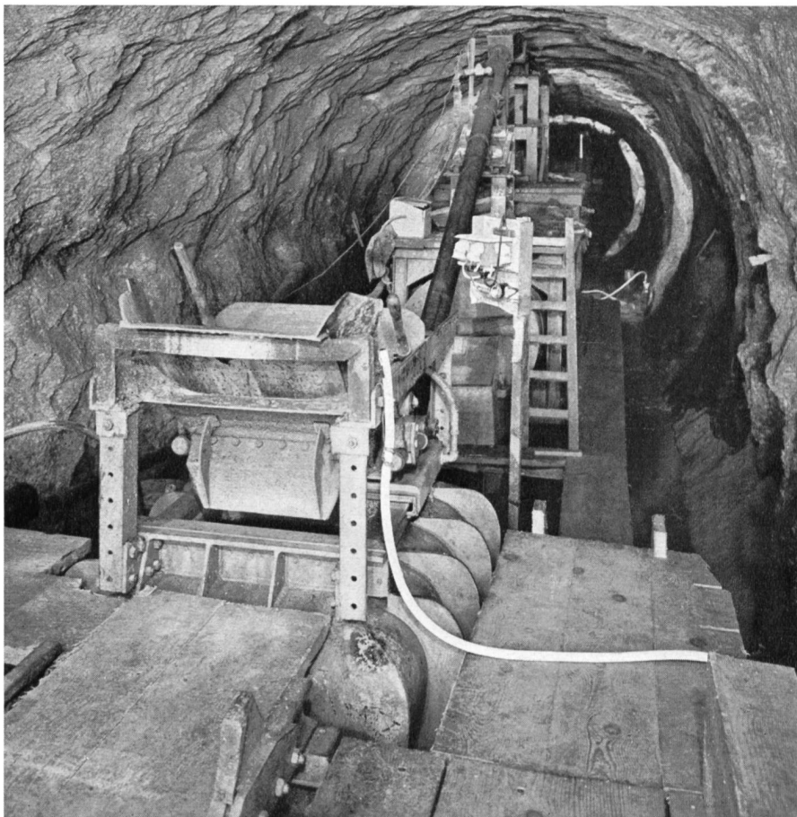
Betonierinstallation mit Press-Weld-Betonpumpe im Stollen Fionnay-Isérables, Kraftwerk Mauvoisin
