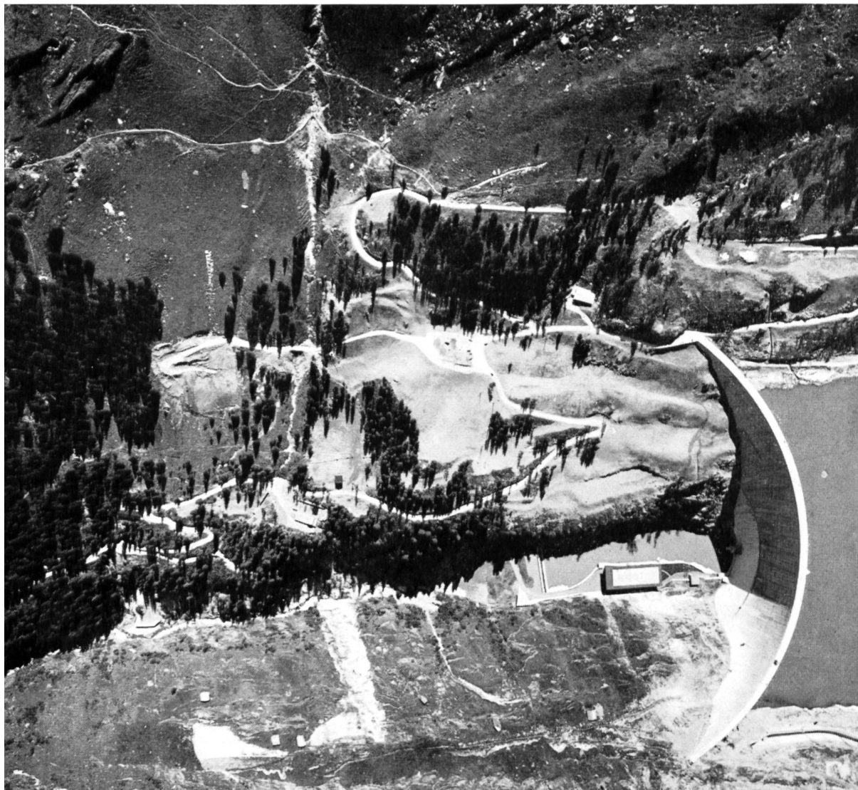
Bild 8 Talsperre Zervreila, aufgenommen mit der Reihenkamera Wild RC7a, f = 100 mm, Flughöhe 700 m über Boden (Aufnahme: Eidg. Vermessungsdirektion)
