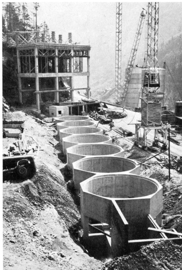
Bild 1 Fundamente der Sandsilos Luzzone: armierte Eisenbetonringe über quadratischem Entnahmestollen
