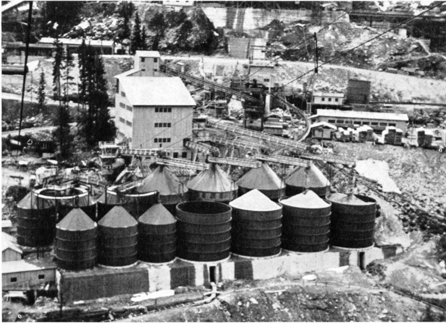
Bild 2 Siloanlage Zervreila; eiserne Silos auf Betonfundamenten mit Entnahmekanälen
