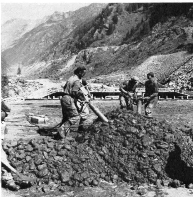
Bild 11. Staumauer Sambuco: Vibratoren Notz GF 125 beim Vibrieren größten Betons
