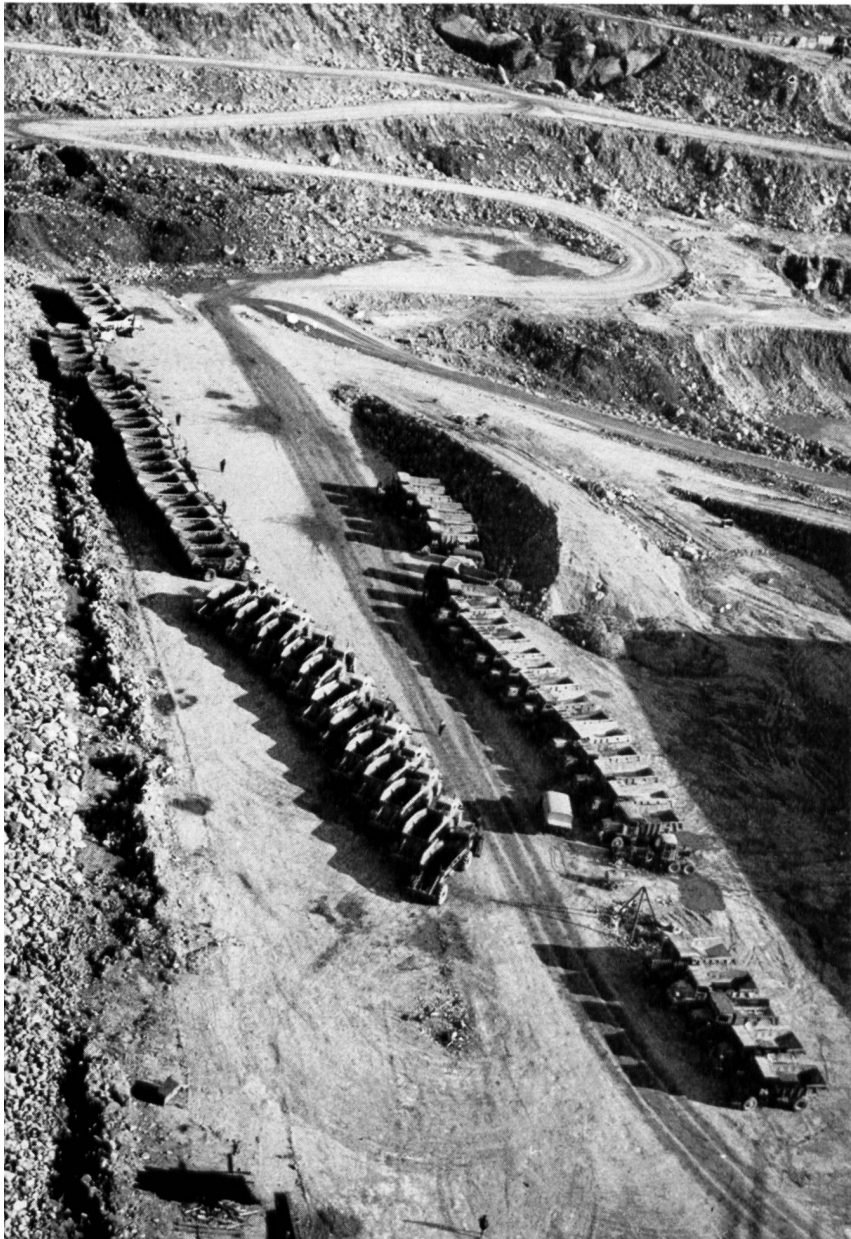
Bild 7 Dammaubstelle Göscheneralp, Fahrzeugpark
