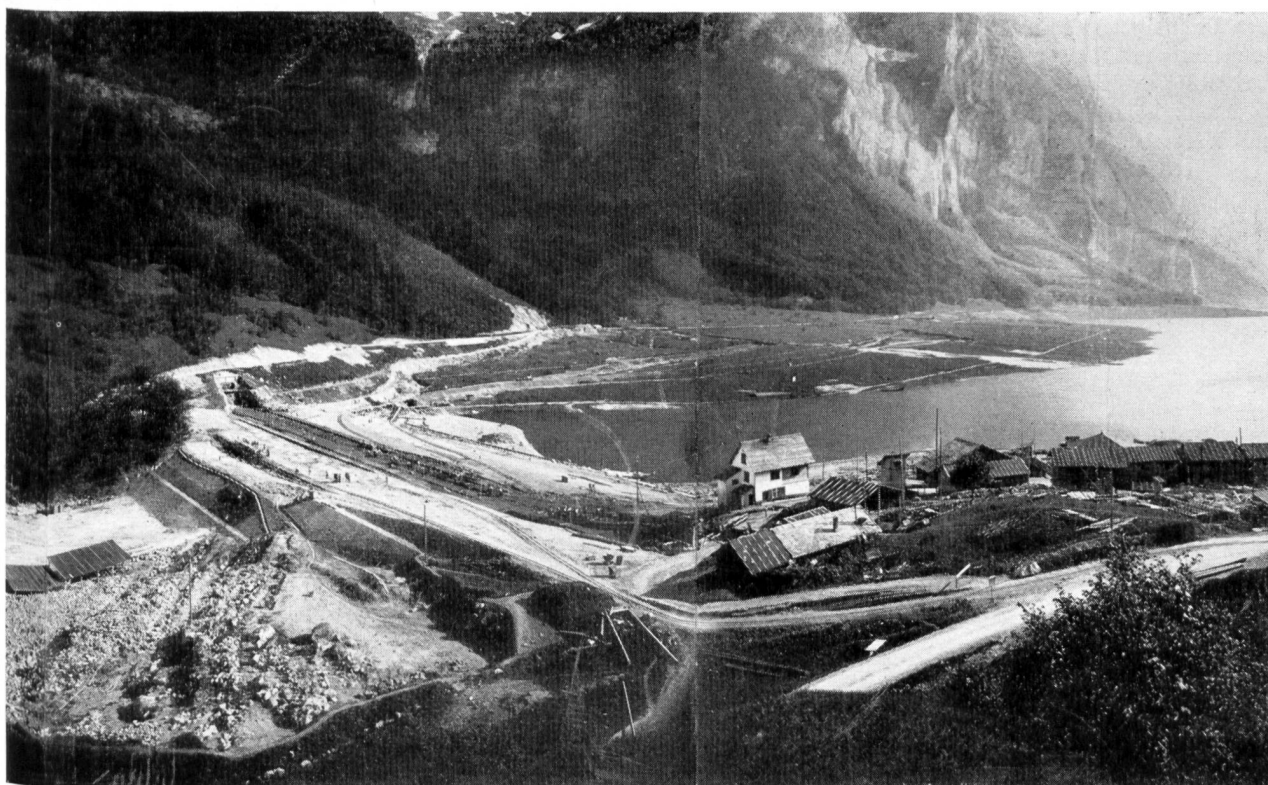
Bild 1 Staudamm Klöntalsee für das Elektrizitätswerk am Löntsch (Bauzustand April 1909)
