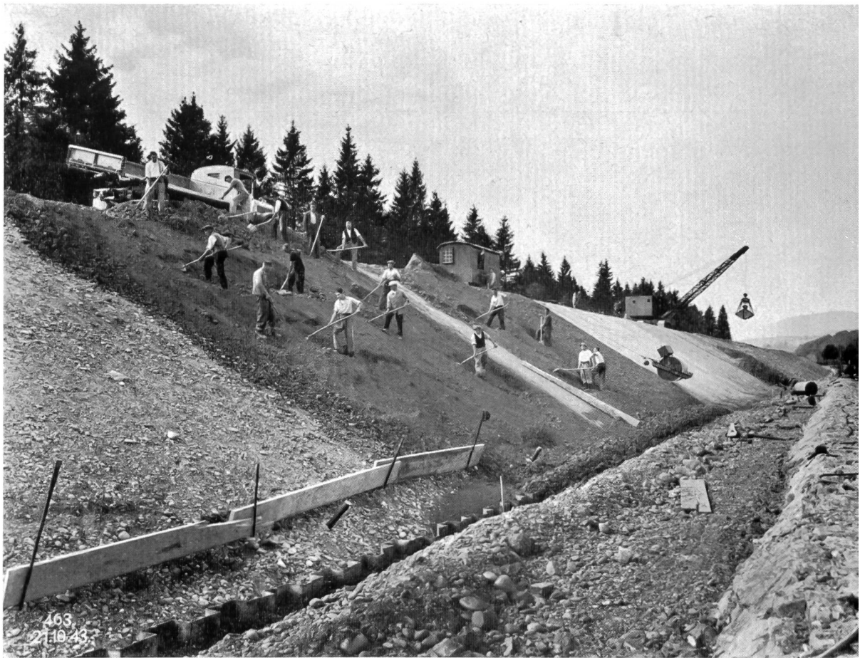
Bild 4 Damm im Staugebiet des Kraftwerkes Ruppertswil—Auenstein: Einbau des Lehmschlages (Bauperiode 1942/45)
