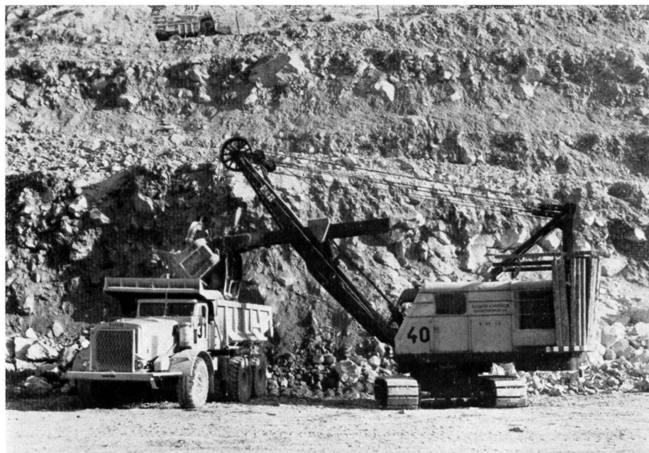
Bild 6 Staudamm Göscheneralp: Beladen eines Großfahrzeuges von 40 t Tragkraft durch einen Bagger mit 3 m 3 Löffelinhalt. Zu beachten ist das äußerst schwere Baggergerät (Bauperiode 1955/61)
