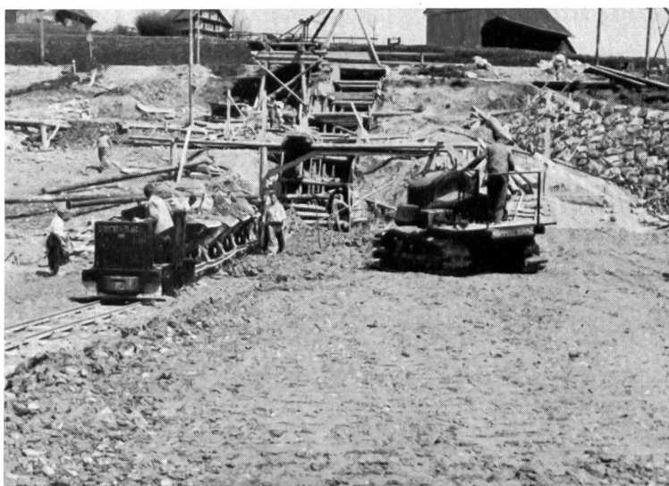
Bild 3 Hühnermatt-Damm: Einwalzen des Lehmkerns (Moräne) mit Raupentruktor 6 t; Einbau Filter mit Rollbahn in Schichten von 30 cm (Bauperiode 1934/36)
