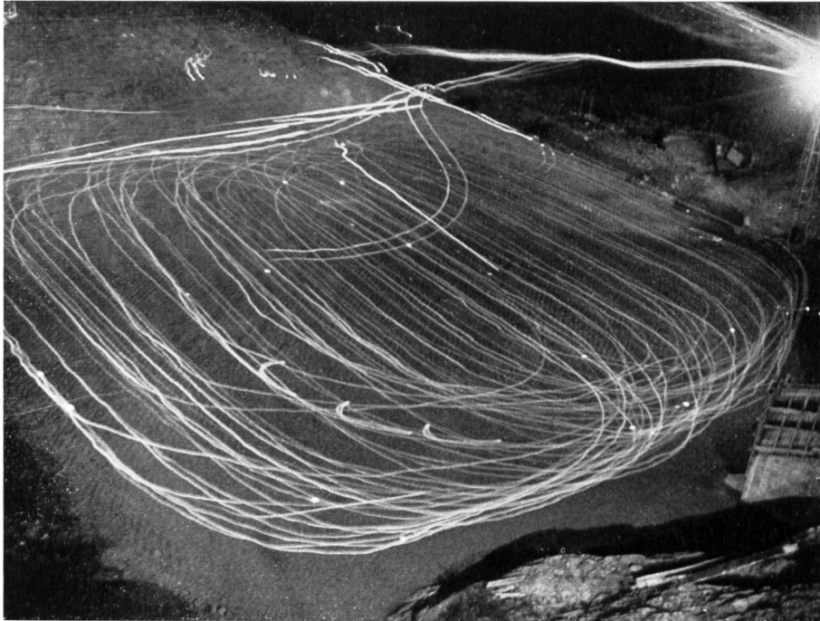
Bild 5 Staudamm Marmorera: Verdichten des Kernmaterials mit Schafffußwalzen, Nachaufnahme (Bauperiode 1950/55)
