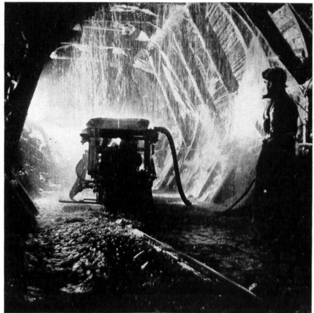
Bild 4 Stollenbagger im Vortrieb bei Wasserandrang
