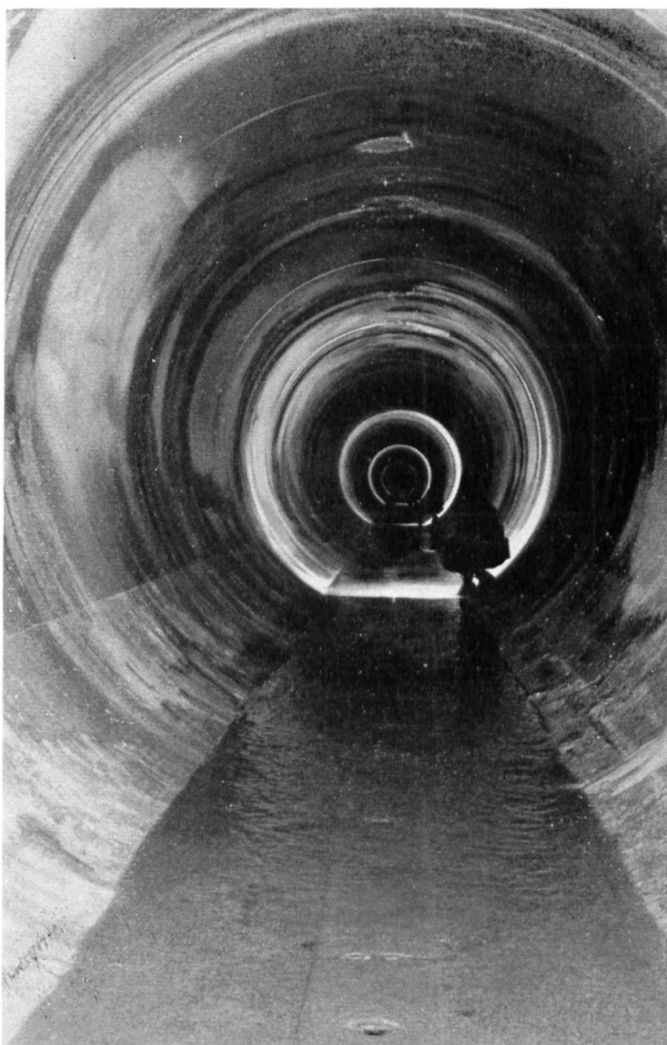
Bild 13 Verkleideter Druckstollen, lichter Durchmesser 3,25 m
