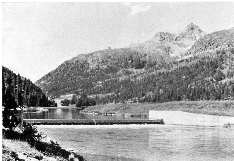
Fig. 7 Barrage à clapet près de Campfèr en Engadine (1947)
