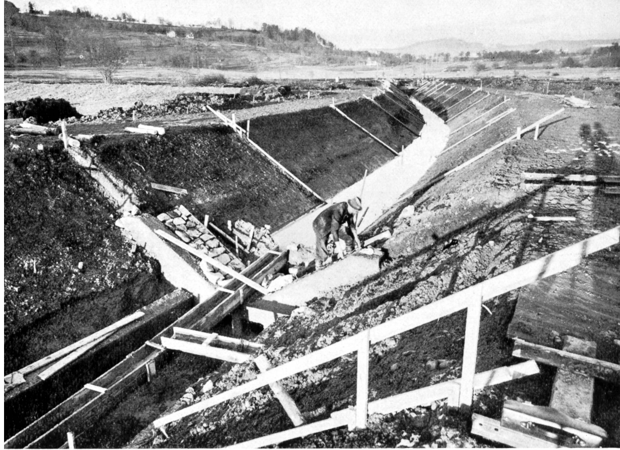
Bild 1 Vorflut-Kanal im Bau
