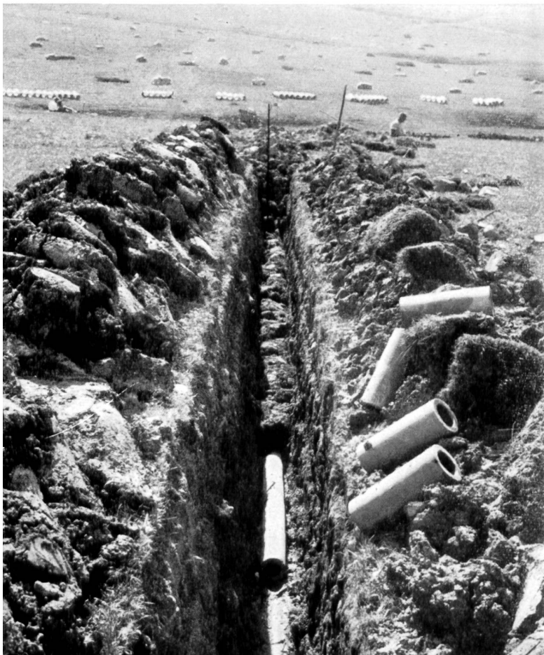
Bild 3 Drainagegraben im Bau
