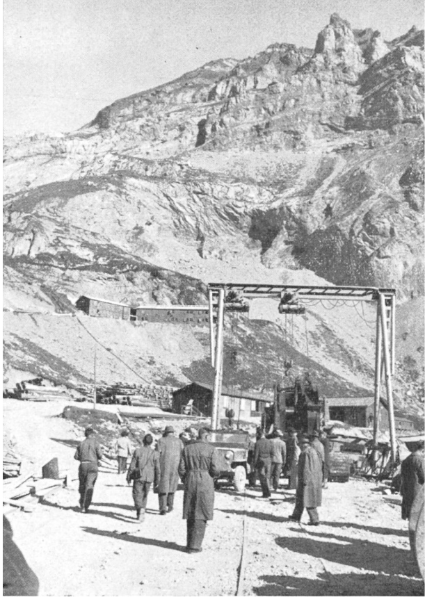
Bild 2 Großbaustelle Limmernboden im Aufbau
