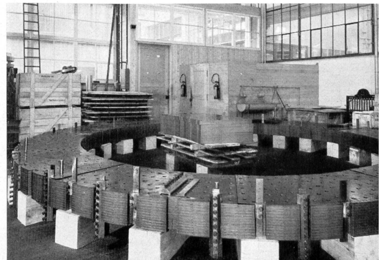
Fig. 9 Montage d'une jante feuilletée de 7,5 m de diamètre avant la mise en place des tiges de serrage (Photo BBC)
