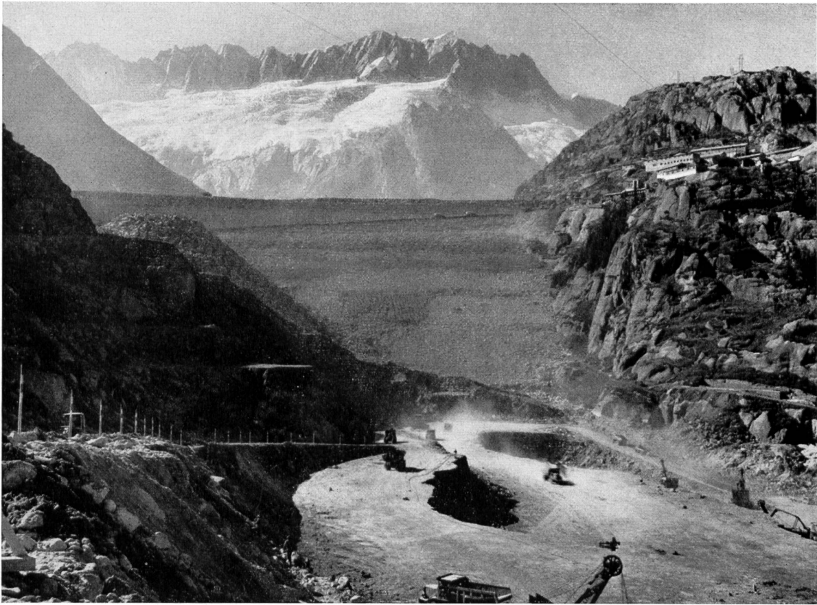
Staudamm Göschenalp des Kraftwerkes Göschenen
