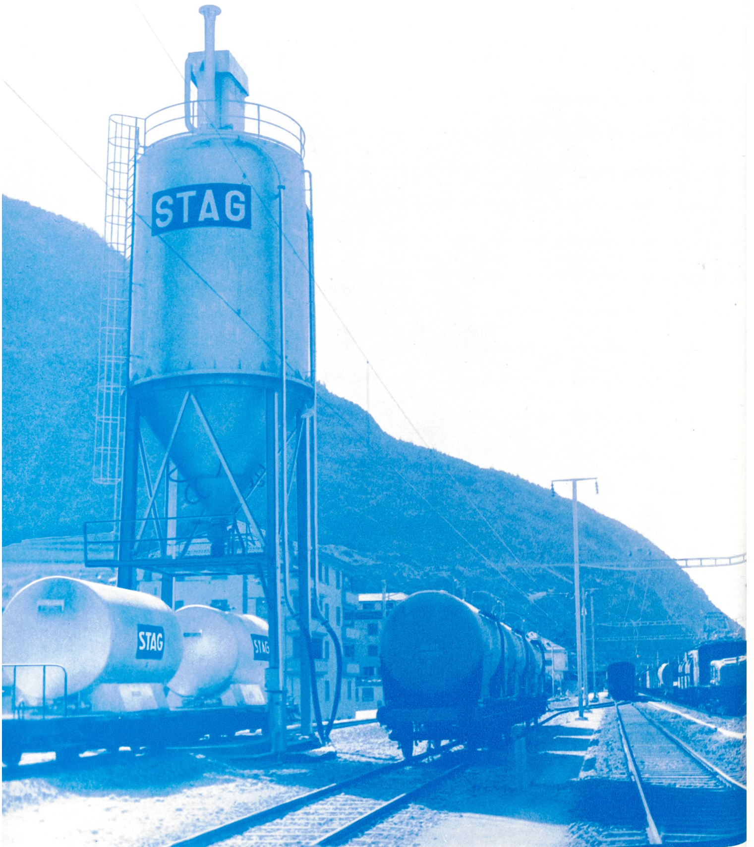
Umschlagsanlage der STAG in Visp (VS)
