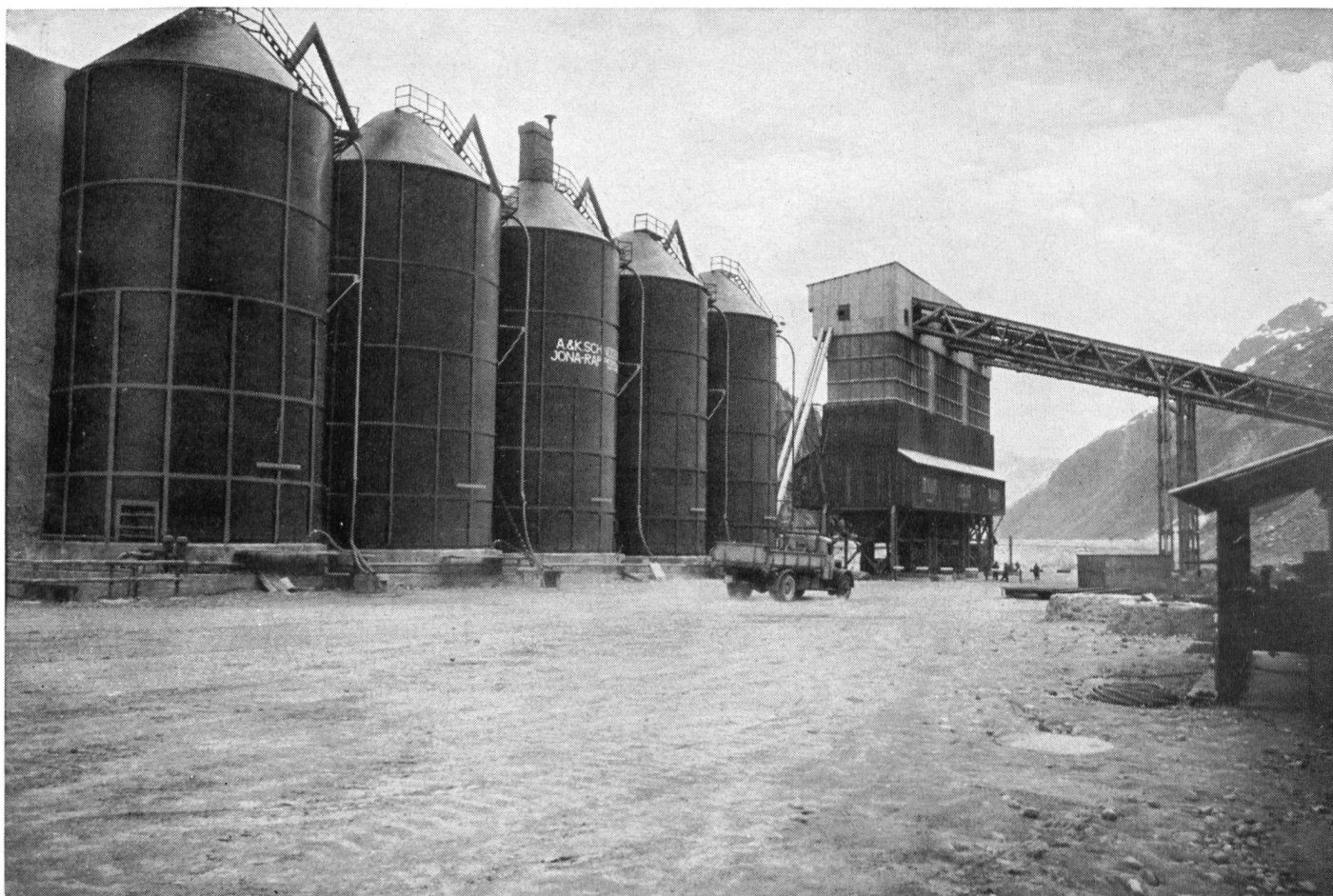
Staudamm Göschenenalp, Tonpulver-Siloanlage, 5 Silo à 1000 m 3 Inhalt
