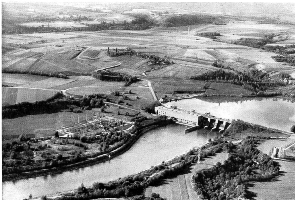
Bild 7 Maschinenhaus und Stauwehr des Rhonekraftwerkes Verbois unterhalb Genf der Services Industriels de Genève (Inbetriebnahme 1943). Schon bei diesem Beispiel zeigt sich deutlich die neue architektonische Entwicklung mit möglichst harmonischer Eingliederung in das Landschaftsbild.
