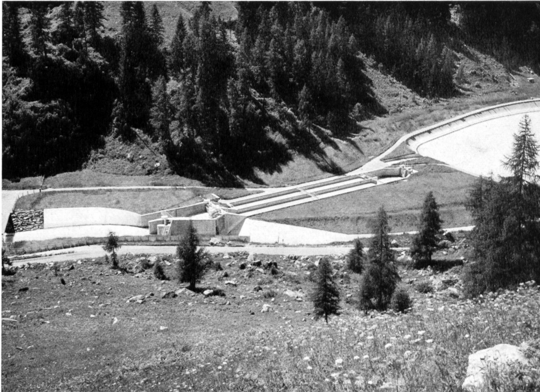
Bild 15 Wasserfassung, Entsandungsanlage und Ausgleichbecken Motec der Kraftwerkgruppe Gougra im Val d'Anniviers
