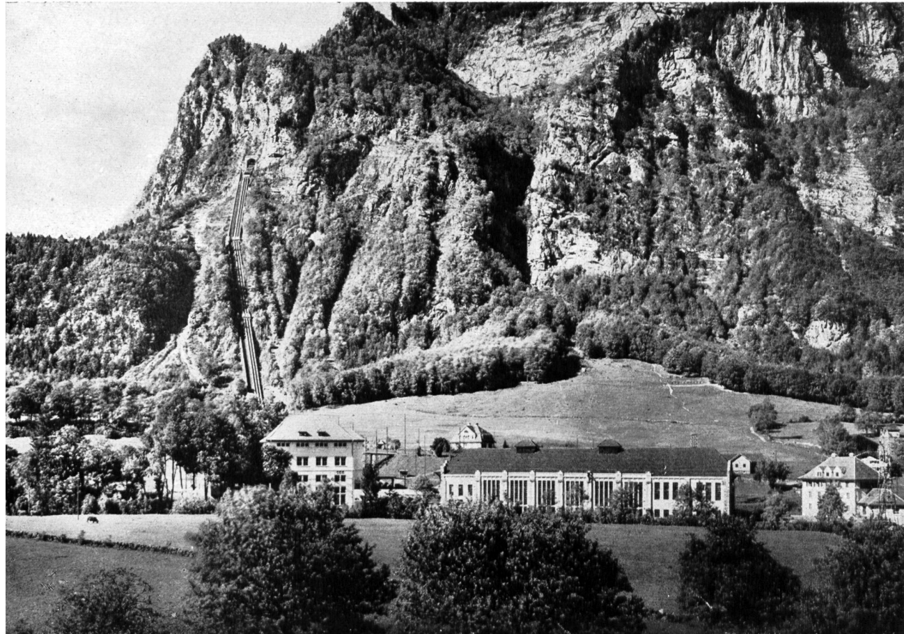
Bild 4 Offen verlegte Druckleitung und Maschinenhaus des Kraftwerkes am Löntsch der NOK; gebaut 1905/1908 durch die AG Motor.
