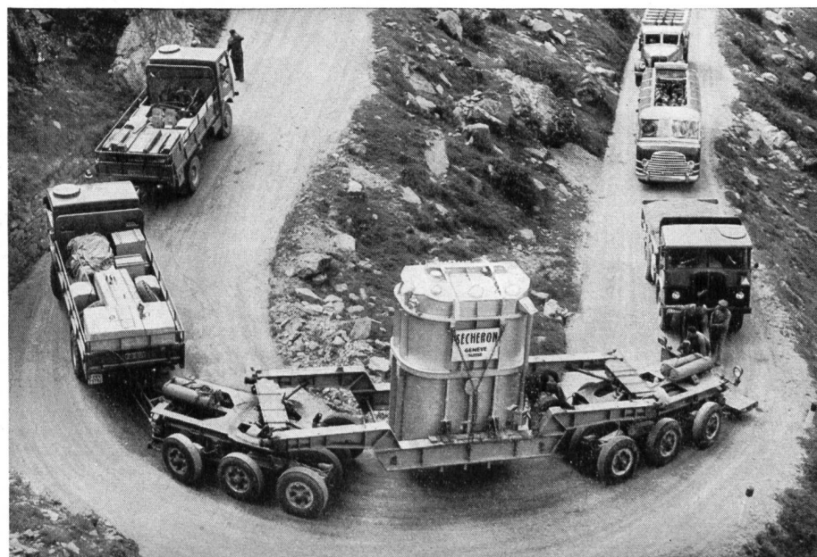
Bild 12 Transport eines 60-Tonnen-Transformators auf der engen und kurvenreichen Gebirgsstraße nach Fionnay. Drei Welti-Furrer-Sträßenschlepper ziehen und stoßen diese Schwerlast auf der 16% steilen Straße nach dem Kraftwerk Mauvoisin.
