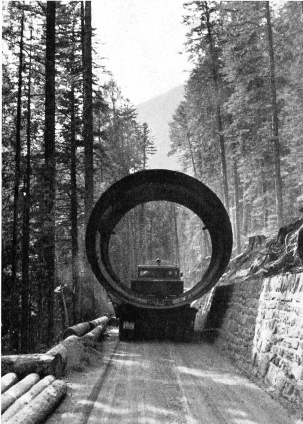
Bild 10 Transport eines Druckrohrs auf einem engen, steilen Waldsträßchen, für die Schachtpanzerung der Stufe Bärenburg-Sils der Kraftwerke Hinterrhein
