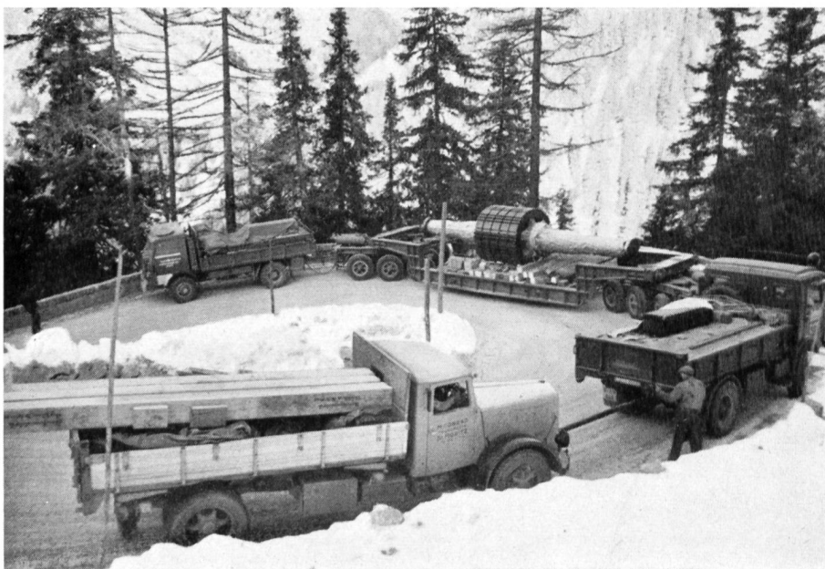
Bild 11 Transport eines 54 Tonnen schweren Rotors von St. Moritz nach der Zentrale Castasegna im Bergell. Langsam überwindet der Schwerlastzug die zahlreichen Kurven des Maloja-Passes; um den Chauffeuren ihre Aufgabe zu erleichtern, sind sie durch Telephon miteinander in ständiger Verbindung.
