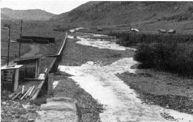
Bilder 4 und 5 Sihl bei Studen vor und nach der Verbauung; Blick vom Geschiebesammler flußabwärts, Blockwurf-Pflasterung der Sohle entsprechend dem geschiebelosen Abfluß unterhalb des Sammlers. (Photo Schmid O. B. I.)
