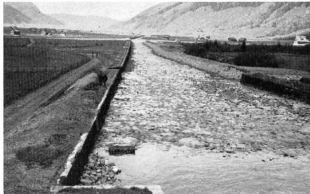
Bilder 4 und 5 Sihl bei Studen vor und nach der Verbauung; Blick vom Geschiebesammler flußabwärts, Blockwurf-Pflasterung der Sohle entsprechend dem geschiebelosen Abfluß unterhalb des Sammlers. (Photo Schmid O. B. I.)
