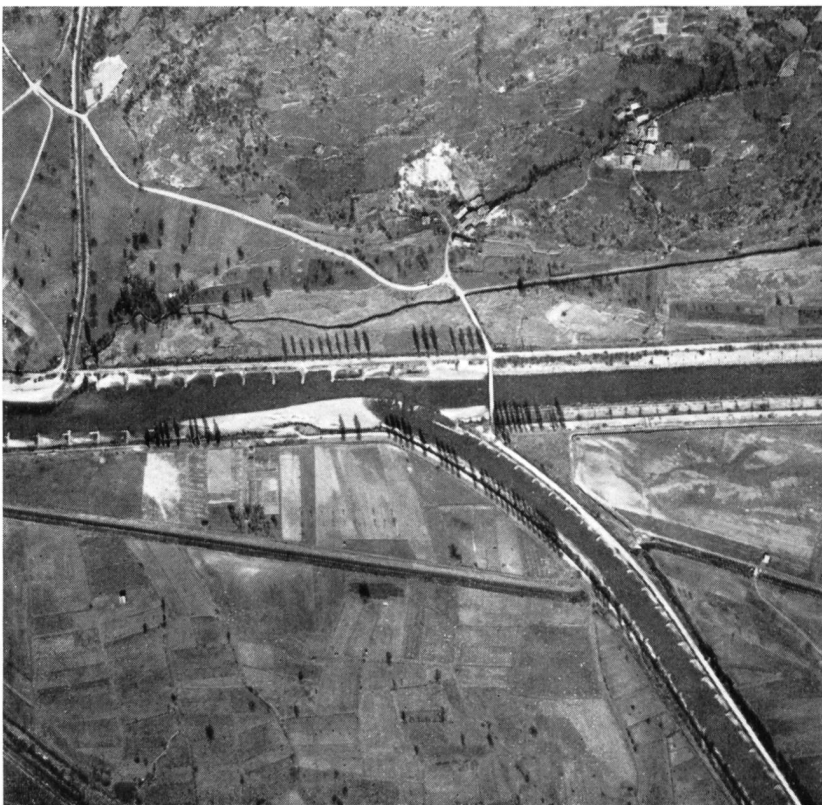
Fig. 3 Le cours du Rhône corrigé près du confluent de la Viège. En amont de cette rivière (à droite sur la photo) nouveau système de correction avec têtes d'épis reliées par des enrochements; en aval ancien système avec têtes d'épis libres.
