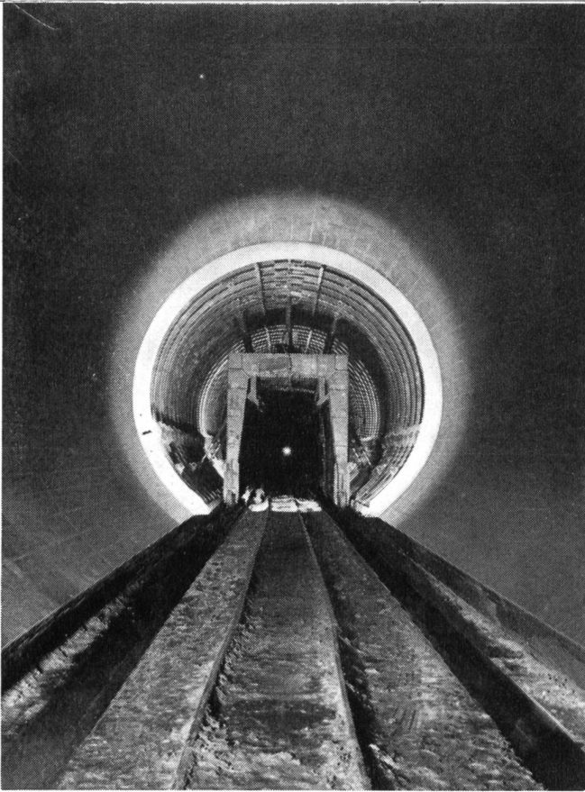
Teleskopschalung im Druckstollen Fenster Avas Kraftwerke Hinterrhein AG
