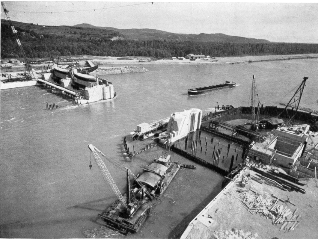
Bild 8 Bau des Stauwehres der Stufe Marckolsheim bei Burkheim unterhalb Breisach, 5. Stufe des Ausbaues Basel—Straßburg für Wasserkraftnutzung und Schifffahrt. Aufnahme August 1960, gleiche Stelle wie bei Bild 1 (Photo H. Baranger, Paris)
