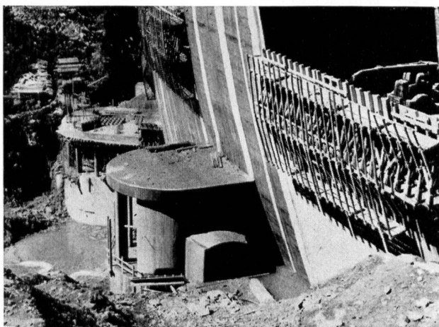
Bild 3 Wasserfassungen am Fuß der Bogenstaumauer Nalps; im Hintergrund Einlauf in den Druckstollen nach Sedrun, vorne Ein- bzw. Auslauf zum Verbindungsdruckstollen nach Santa Maria und zum Grundablaß (Photo A. Sonderegger vom 10. September 1960)
