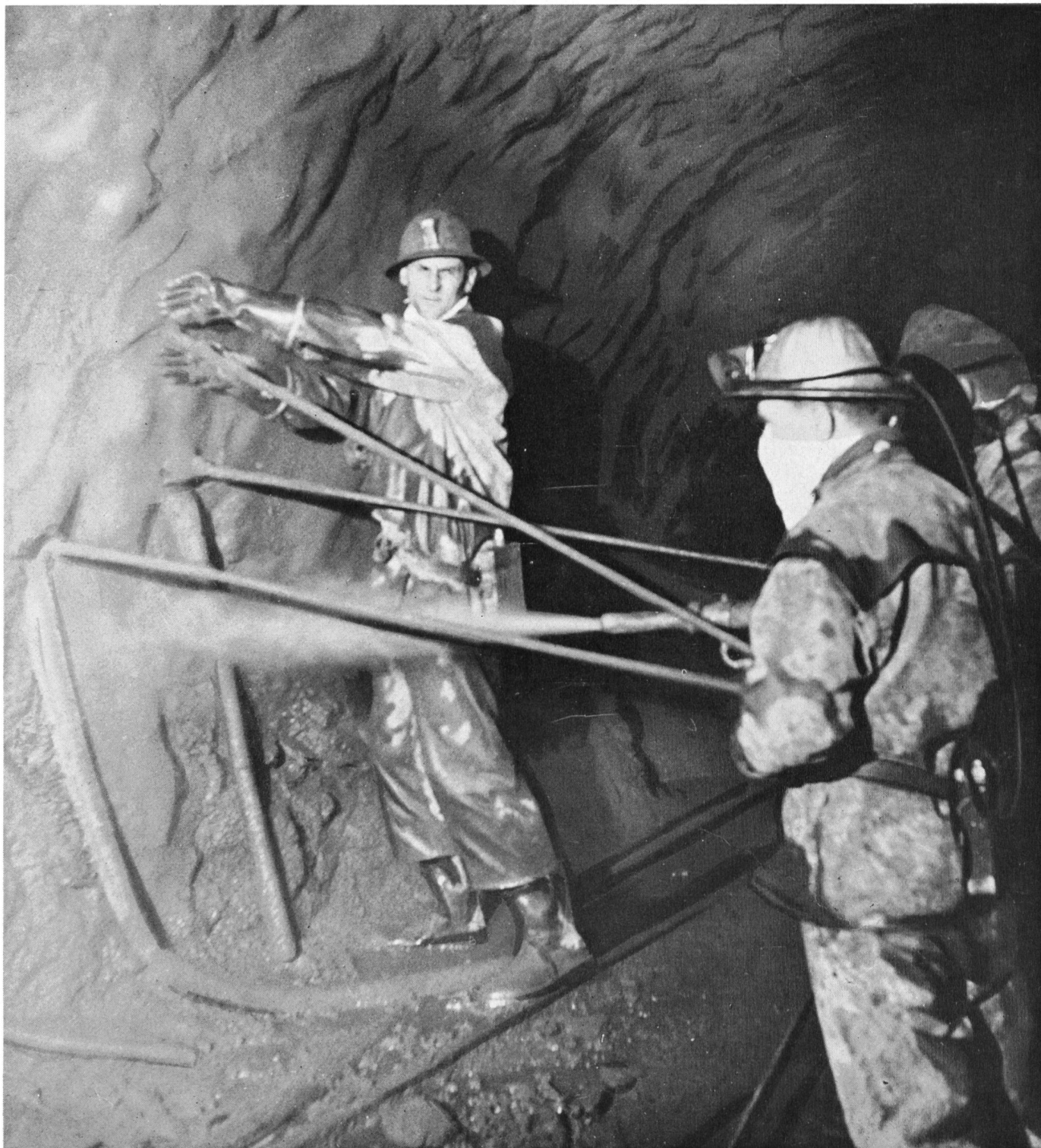
Unsere Spezialisten beim Abdichten eines Stollens
