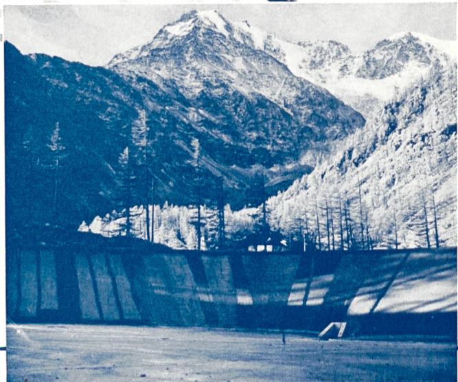
Ausgleichsbecken «Eggen» der Energie Electrique du Simplon
