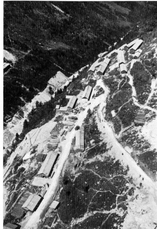
Arbeiterunterkünfte am steilen rechtsseitigen Talhang unterhalb der Sperrstelle Valle di Lei
