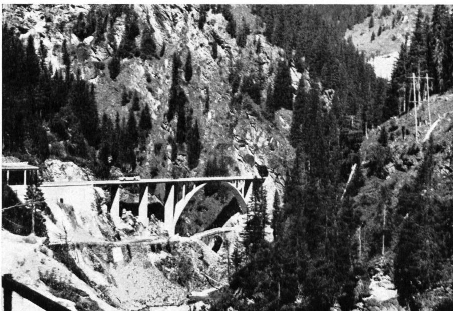
Die alte kleine Brücke und die neue elegante Bogenbrücke der Averserstraße über den Reno di Lei bei seinem Eintritt in die Schweiz; seine wilde, unzugängliche Schlucht ist noch italienisches Gebiet, die Grenze reicht bis hart an die alte Straßenbrücke
