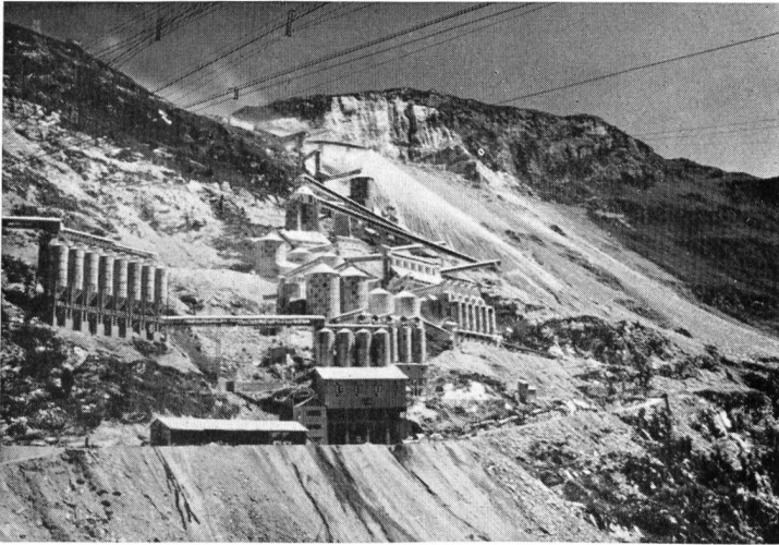
In der Höhe stark gestaffelte Anlagen für die Aufbereitung der Betonzuschlagstoffe, Zementsilos und Betonfabrik am rechten Talhang
