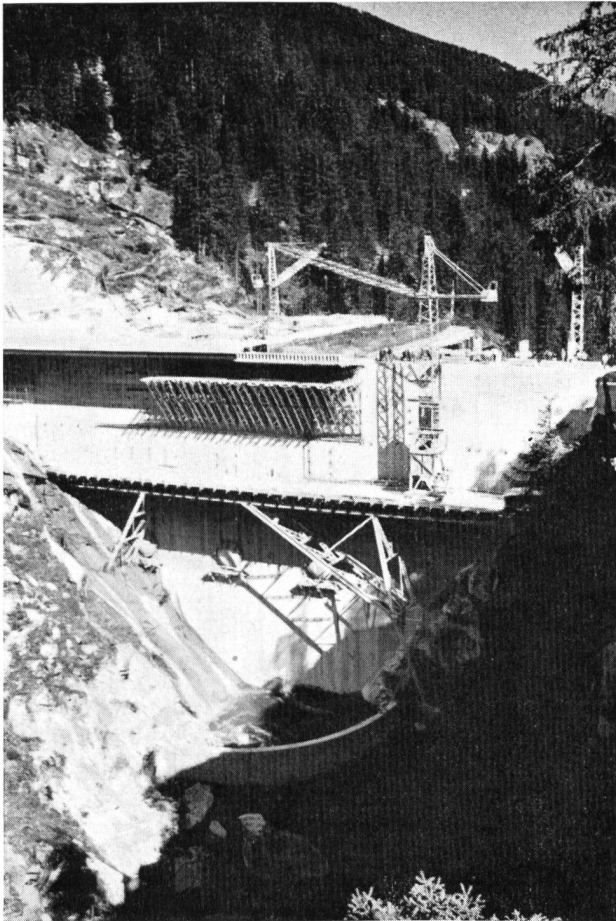
Talsperre Bärenburg kurz vor der Vollendung; die Maschinenaggregate der Kraftwerkstufe Sufers—Bärenburg sind im oberen Teil der Talsperre untergebracht, die zugehörige Schaltanlage wird auf der Staumauerkrone errichtet
