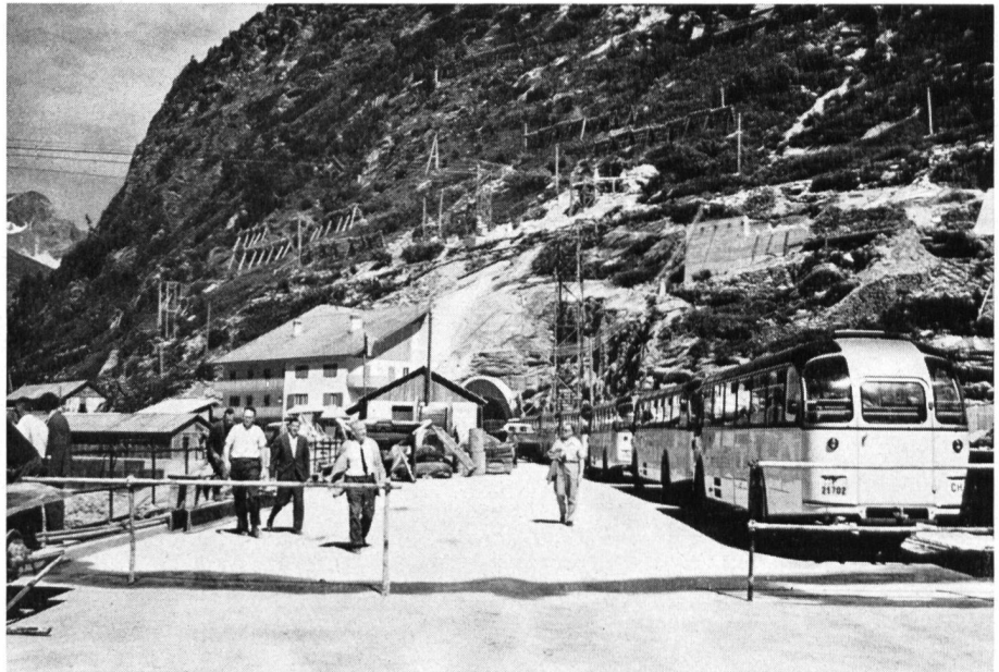
Unsere sechs Postautos modernsten Typs bereit zur Abfahrt auf der Baustelle Valle di Lei; im Zentrum des Bildes ist das Portal des 1 km langen Grenztunnels der Zufahrtstraße sichtbar
