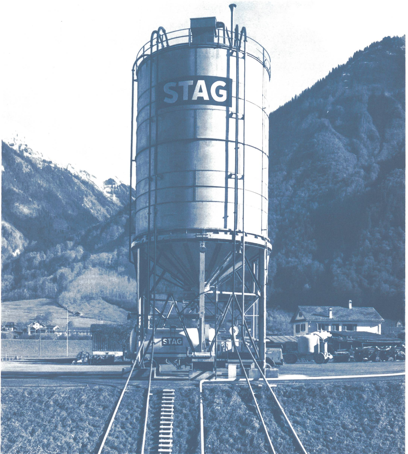
Umschlagsanlage der STAG in Linthal/GL: 1 Silo von ca. 1200 t Fassungsvermögen unterm Silo Transportbehälter von 16 t Nutzlast auf Sattelschlepper
