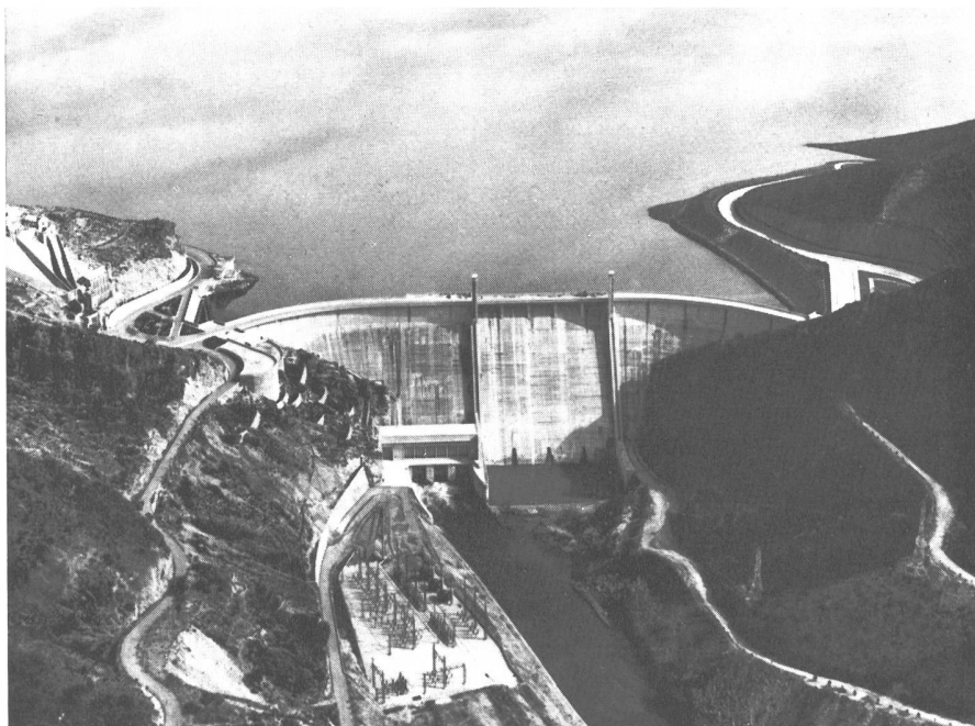
Bild 17 Stausee Buendía am Río Guadiela im Tajo-Becken (im Plan Zone IX, Nr. 24) Staumauerhöhe 80,25 m, Speichereinhalt 1571 Mio m 3 , erstellt 1958
