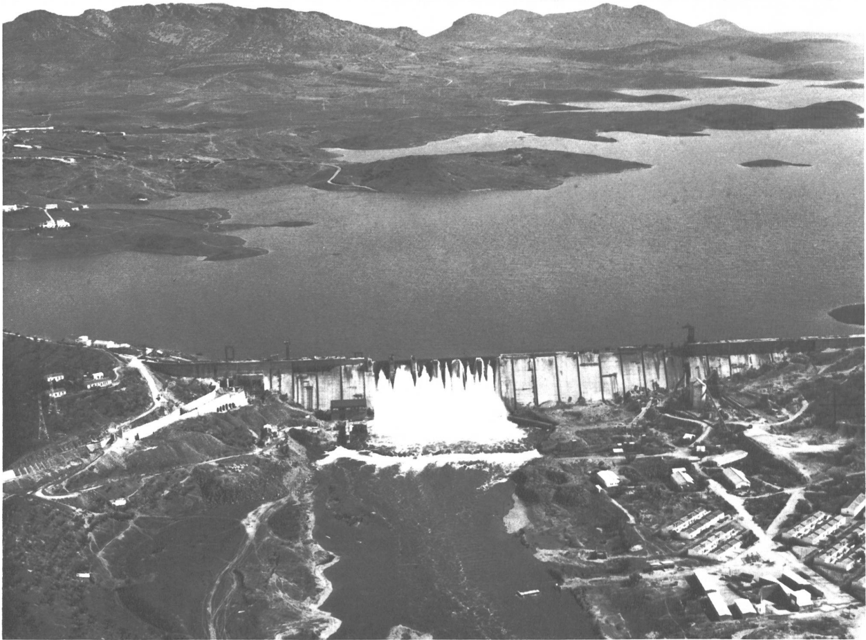
Bild 19 Stausee Orellana am Río Guadiana (im Plan Zone VIII, Nr. 4) Staumauerhöhe 61 m, Speichereinhalt 800 Mio m 3 , Fertigstellung 1961
