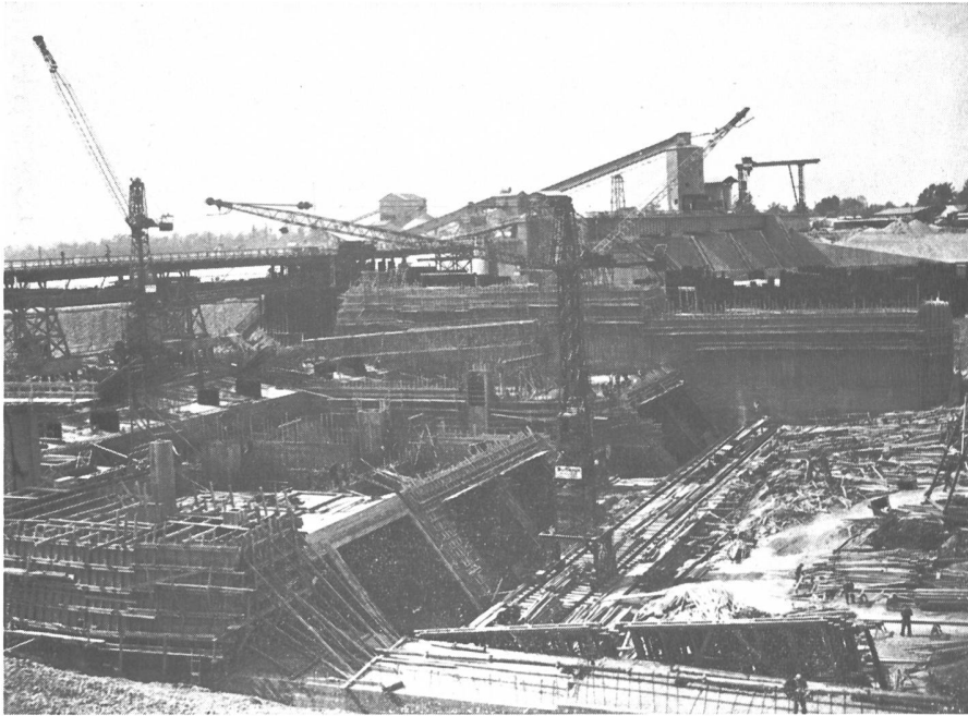
Bild 1 Baustelle der Innstufe Schärding- Neuhaus; Blick auf die Baugrube «B», 16. September 1960. (Photo Österreichisch-Bayerische Kraftwerke AG, Simbach/Inn)
