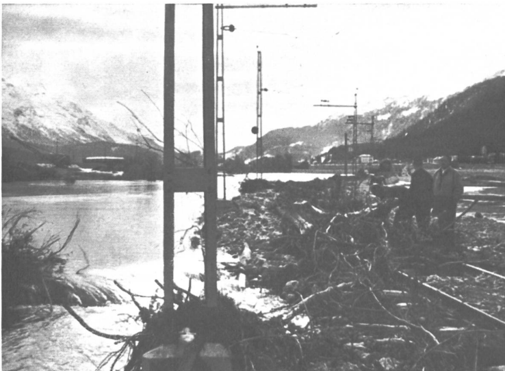
Bild 3 Durch Hochwasser des Inn unterbrochene Linie der Rhätischen Bahn zwischen Bever und La Punt; Blick talaufwärts
