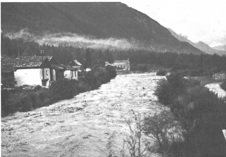
Bild 7 Die hochwasserführende Maira bei Vicosoprano unterhalb der Brücke S. Cassiano
