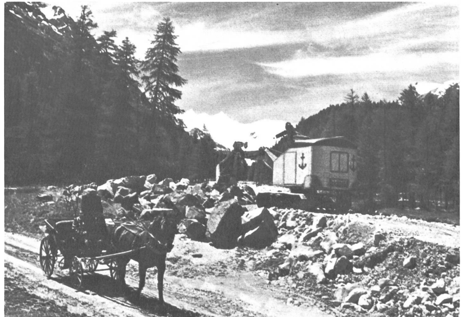
Bild 5 Bau von Hochwasserschutzdämmen im Val Roseg mit Einsatz moderner Großgeräte; im Hintergrund die stark verschneite Sellagruppe (Aufnahme vom Sommer 1960)
