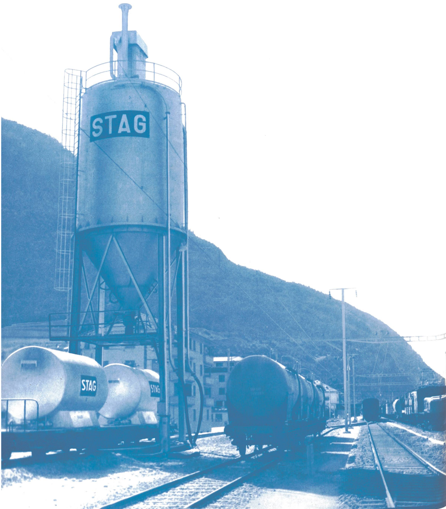
Umschlagsanlage der STAG in Visp (VS)
