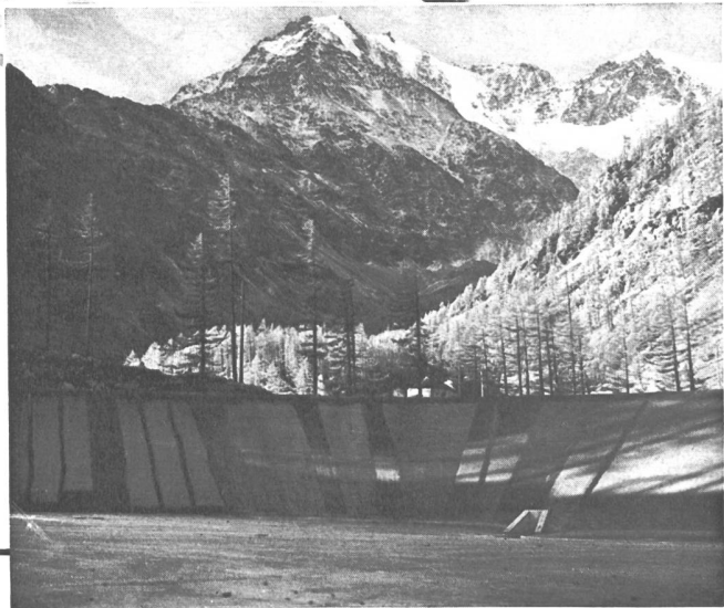
Ausgleichsbecken «Eggen» der Energie Electrique du Simplon
