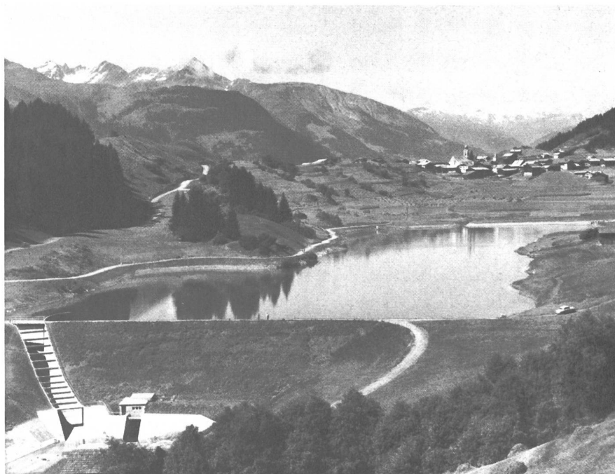
Staudamm Brigels, Abdichtung des Untergrundes durch Injektionsschirm mit OPALIT
