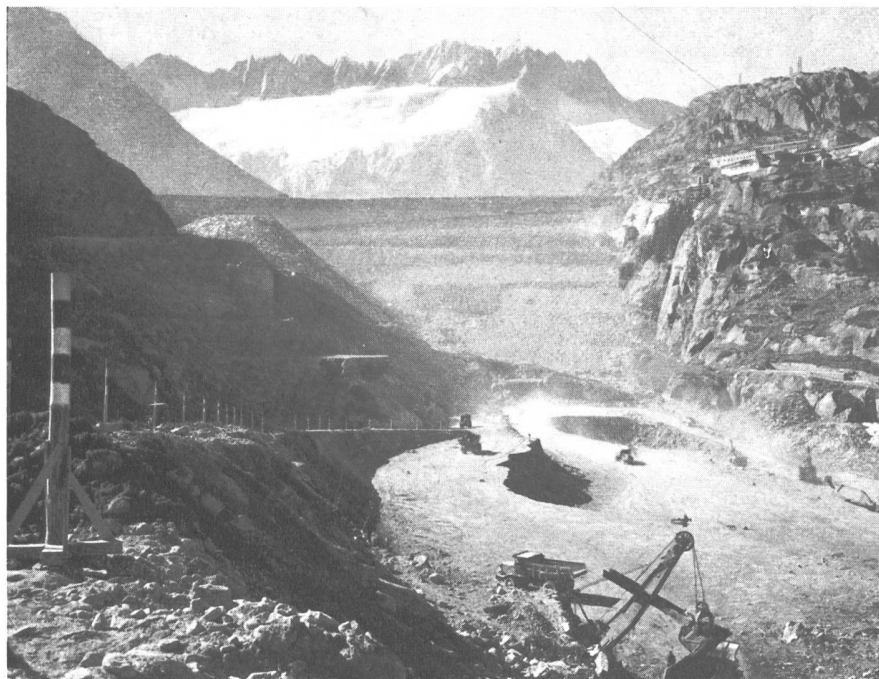
Staudamm Göscheneralp, versehen mit OPALIT-Dichtungskern
