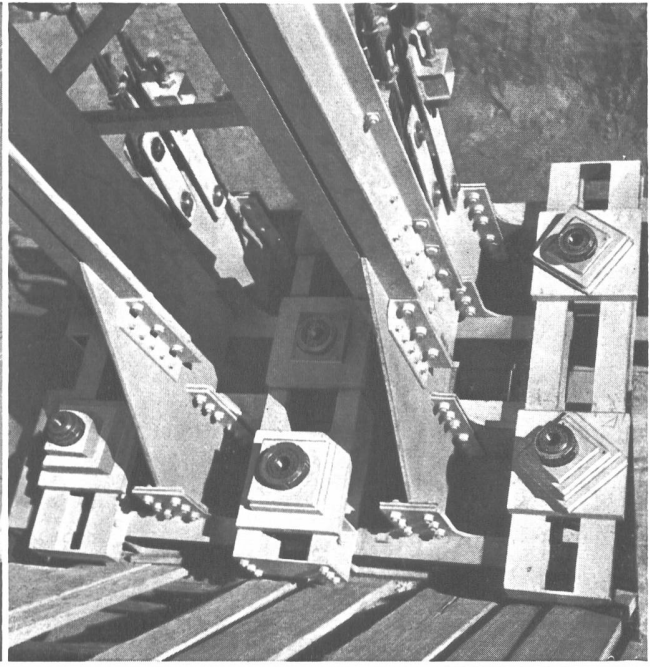
Verankerung der schrägen Zugstreben mit BBRV-Felsanker
