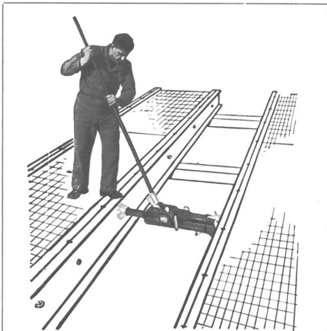
«Simplex» 20-t-Gelenkfußwinde Nr. 2030 mit 480 mm Hub und angepaßtem Ziegenfuß. Das Gas- und Wasserwerk Winterthur hat mit dieser Winde, so wie hier dargestellt, einige tausend Sondierpfähle ausgezogen.
