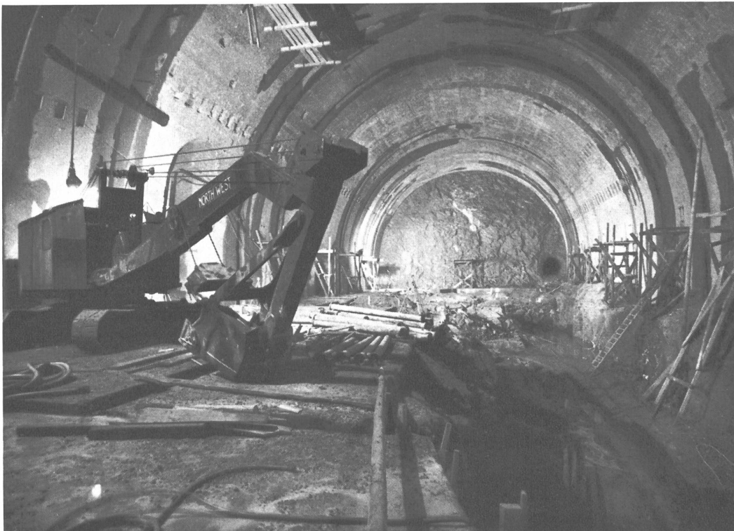
Bild 15 Zentrale Olivone, Bauzustand Mitte August 1960 (Ausbruch und Gewölbeverkleidung abgeschlossen)
