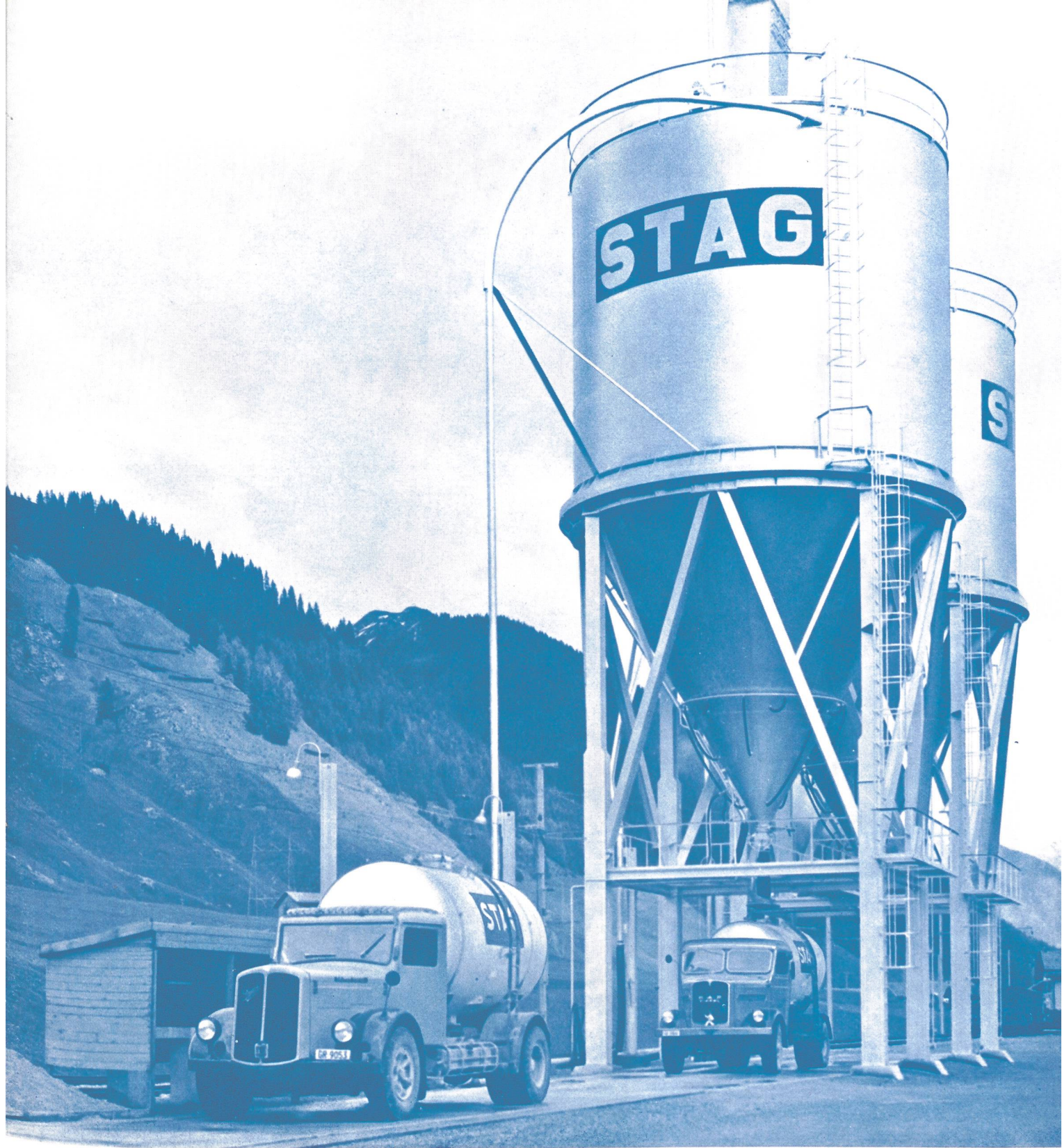
Umschlagsanlage der STAG in Sedrun
