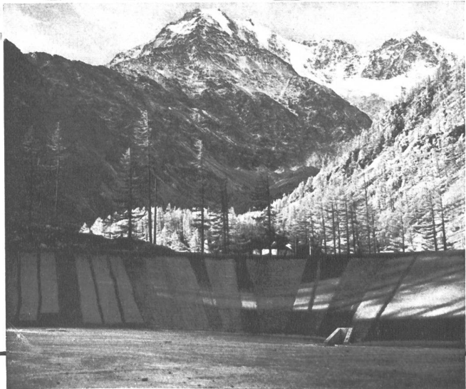
Ausgleichsbecken «Eggen» der Energie Electric du Simplon
