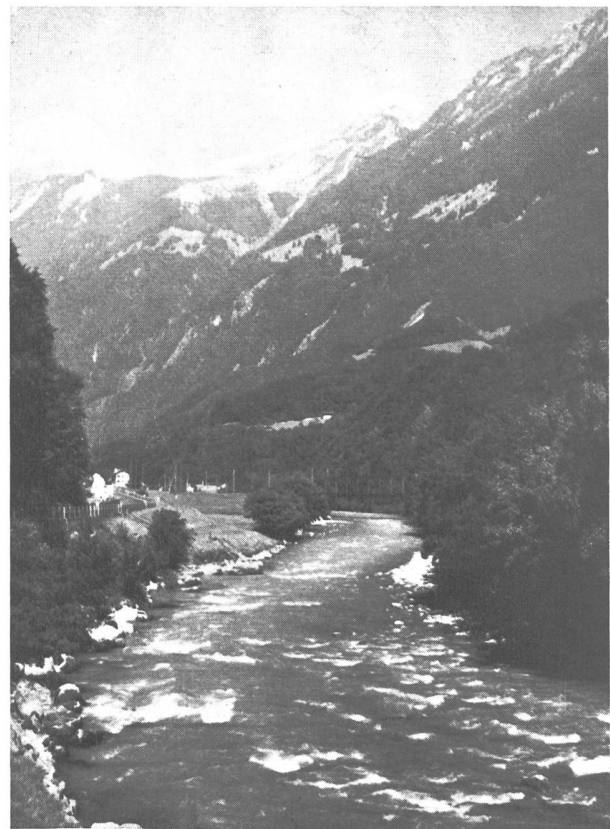
Bild 4 Linth unterhalb Schwanden, Blick flußabwärts
